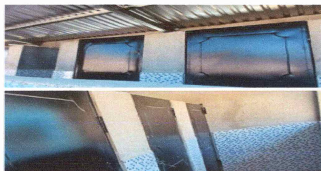
Foto 3: SUSTITUCIÓN DE PUERTA EN SERVICIOS SANITARIOS
