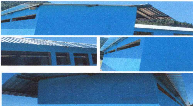
Foto 4: PINTURA EN MUROS EXTERIORES E INTERIORES
