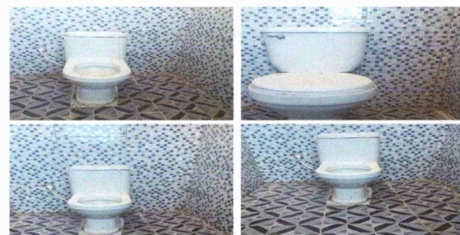
Foto 5: SUSTITUCIÓN DE INODORO
