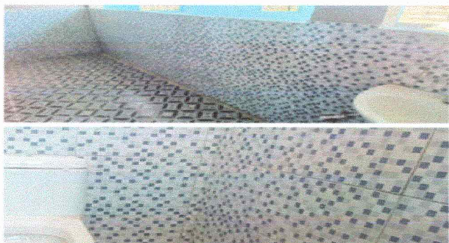
Foto 8: INSTALACIÓN DE AZULEJO EN SERVICIO SANITARIO
