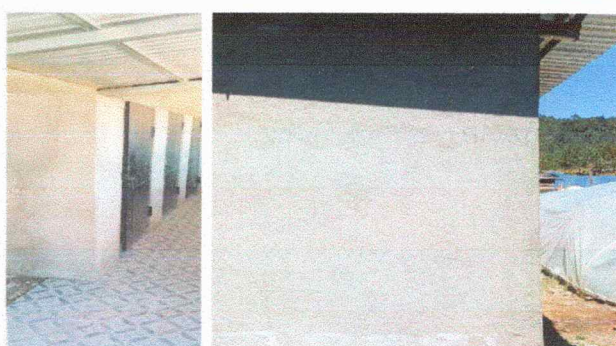
Foto 11: REPARACIÓN DE MURO
