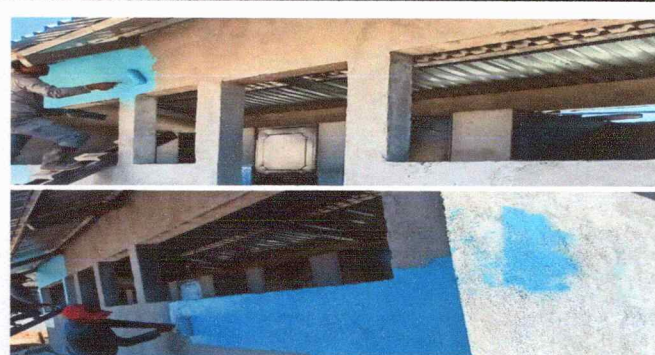
Foto 4: PINTURA EN MUROS EXTERIORES E INTERIORES
