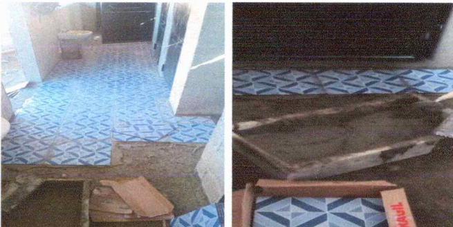
Foto 6: INSTALACION DE PISO EN SERVICIO SANITARIO
