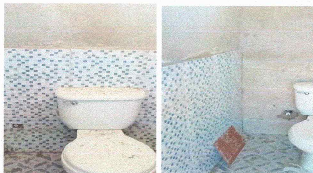
Foto 8: INSTALACIÓN DE AZULEJO EN SERVICIO SANITARIO
