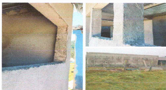
Foto 10: REPELLO EN MURO
