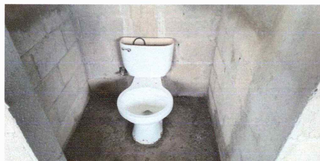
Foto 5: SUSTITUCIÓN DE INODORO
