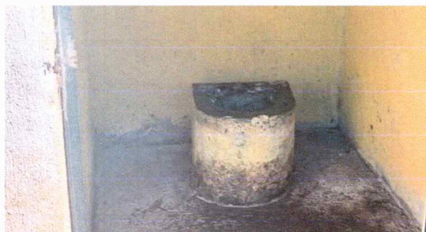
Foto 5: SUSTITUCIÓN DE INODORO
