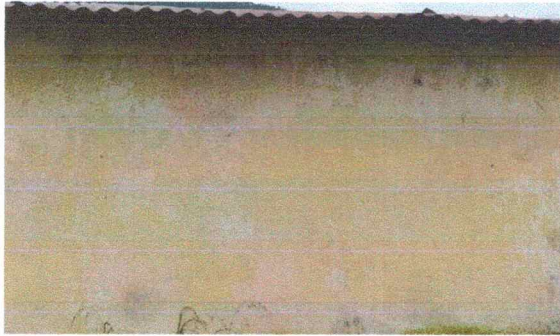
Foto 10: REPELLO EN MURO
