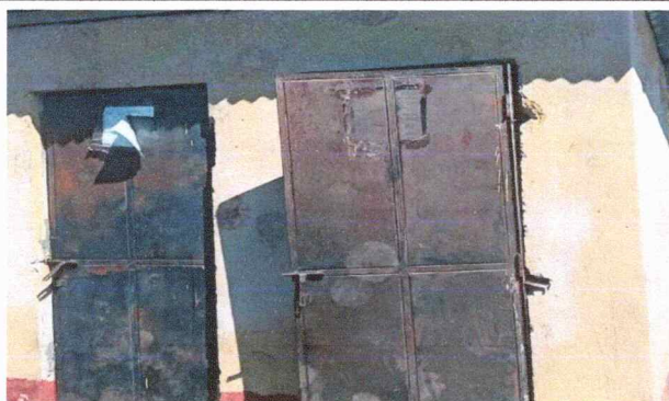
Foto 3: SUSTITUCIÓN DE PUERTA EN SERVICIOS SANITARIOS
