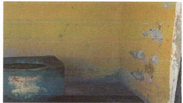
Foto 11: REPARACIÓN DE MURO
