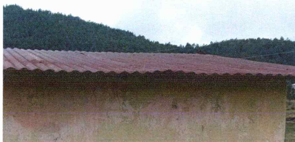
Foto1: SUSTITUCIÓN DE LAMINA, POR LAMINA TROQUELADA ALUZINC CALIBRE 26
