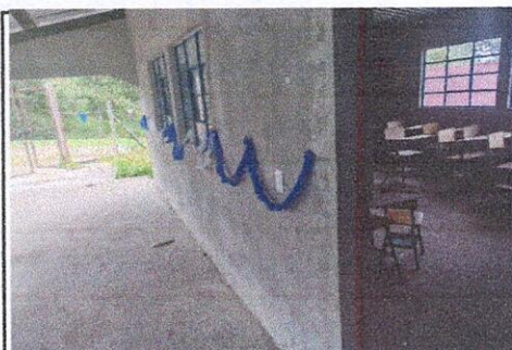
PINTURA EN AULAS
