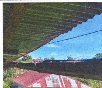
Foto 6: SUSTITUCIÓN DE CANAL DE METAL
