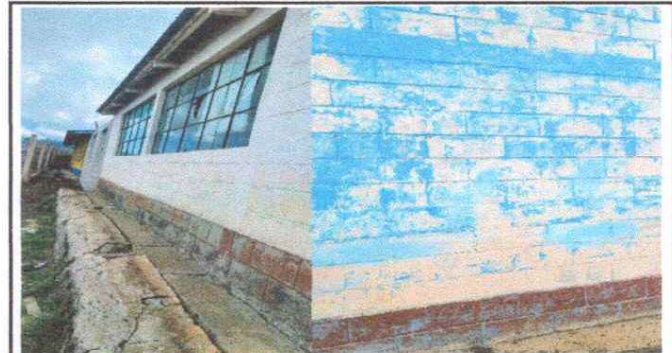
Foto 4: Mejoramiento de pintura de paredes exteriores e interiores
