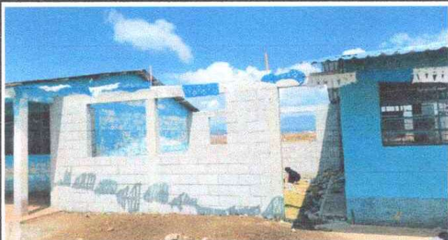
Foto1: Mejoramiento de lámina, por lámina troquelada calibre 26
