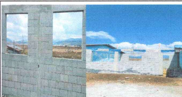
Foto 6: Mejoramiento de ventanas , varias dimensiones
