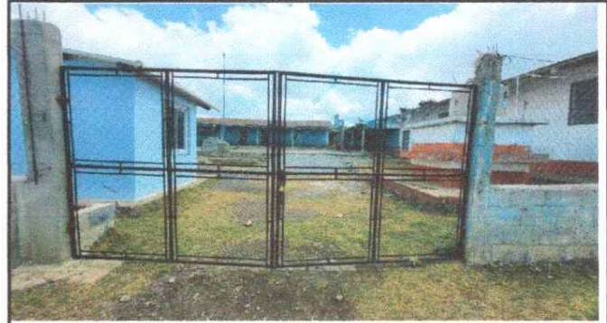
Foto 2: Sustitución de portón principal de 4.15 X 2.40
