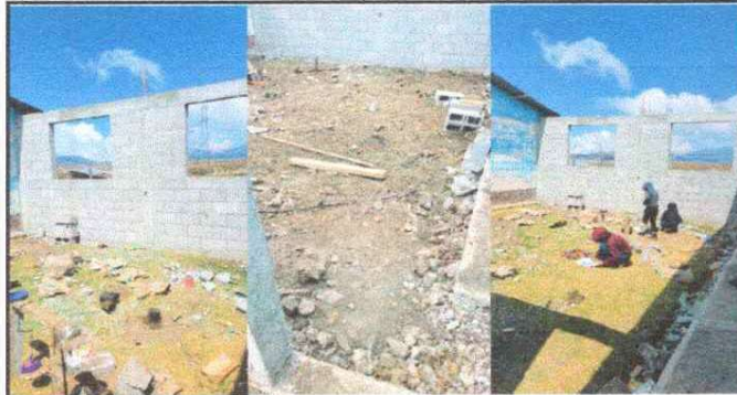
Foto1: Mejoramiento de piso de cemento líquido
