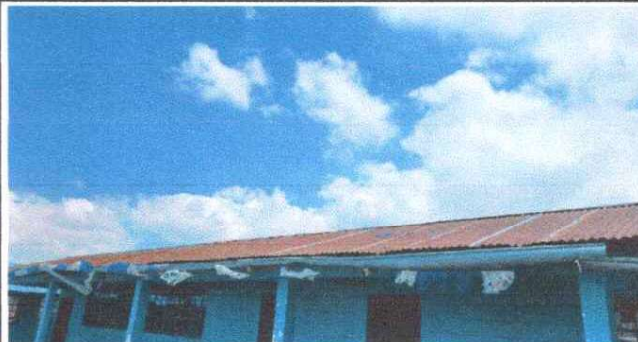
Foto 2: Sustitución de lámina, por lámina troquelada calibre 26
