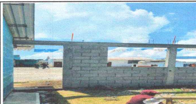
Foto 3: Mejoramiento de estructura de soporte de madera, por metal.
