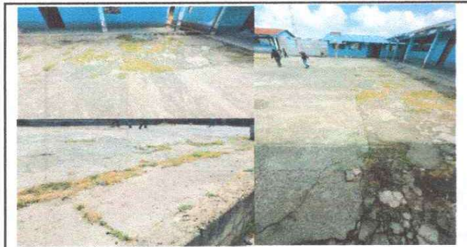
Foto 3: Sustitución de losa del patio
