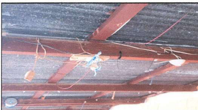
Foto 4: Reparación de Sistema Eléctrico
