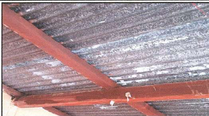
Foto 2: Sustrucción de estructura de madera por metal
