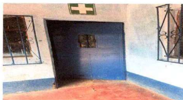
FOTO 4: REPARACIÓN DE PUERTAS: Aplicación de pintura de puerta de metal.
