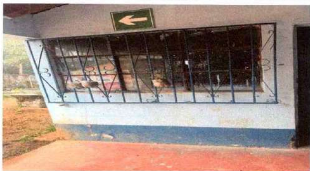
FOTO 1: SUSTITUCION DE VENTANAS: Sustitución de ventana de metal.
