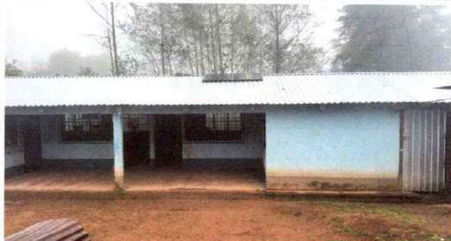
FOTO 4: PINTURA EN PAREDES EXTERIORES: Aplicación de pintura en muro exterior.
