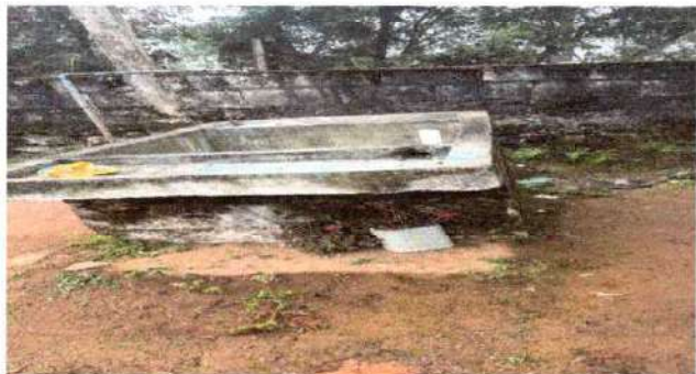
FOTO 1: SUSTITUCIÓN DE PILA: Sustrucción de pila artesanal por una pila de concreto.
