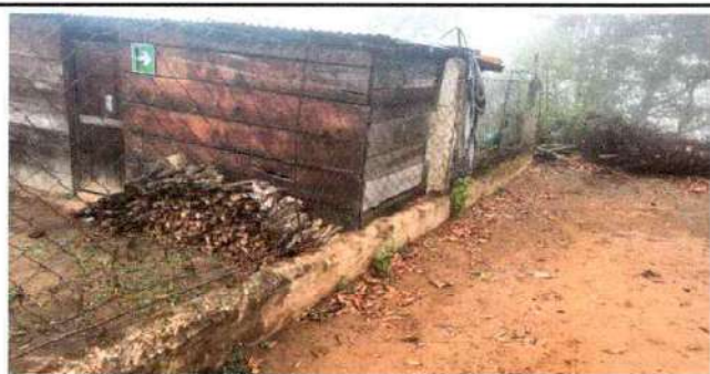
FOTO 5 : REPARACION DE CIRCULACION: Reparación de muro perimetral con tubo hg y malla galvanizada
