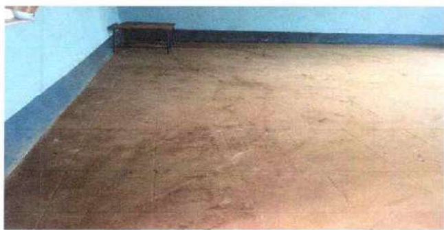
FOTO 3: PINTURA EN PAREDES: Aplicación de pintura en muros interiores.
