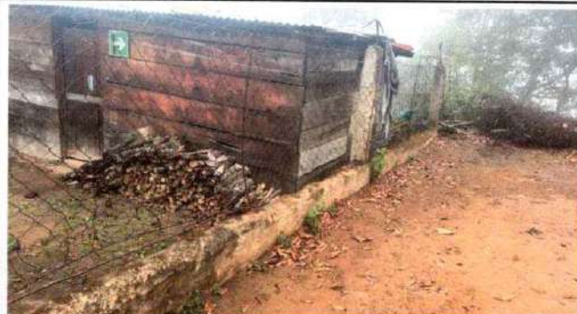
FOTO 2: MEJORAMIENTO EN CIRCULACION: Reparación de muro perimetral con tubo hg y malla galvanizada.
