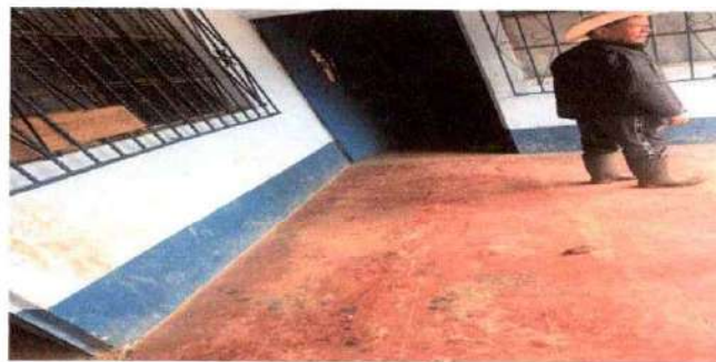
FOTO 2: PINTURA EN PAREDES: Aplicación de pintura en muros exteriores.
