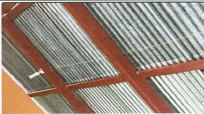
SUSTITUCIÓN DE ESTRUCTURA DE SOPORTE DE TECHO
