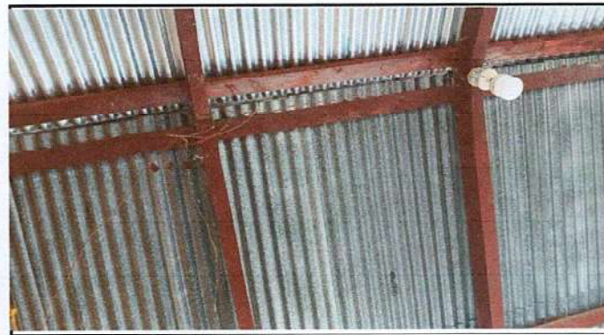
SUSTITUCION DE PLAFONERAS
