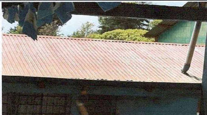
SUSTITUCIÓN DE LAMINA
