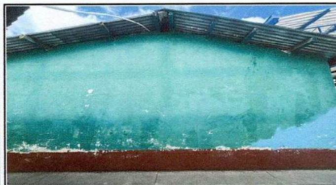
PINTURA EN MUROS EXTERIORES E INTERIORES
