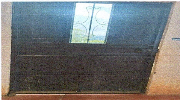
Foto1:Mantenimiento de la estructura, lijado, cambio de tubo, cepillado, sujeciones y aplicación de pintura.
