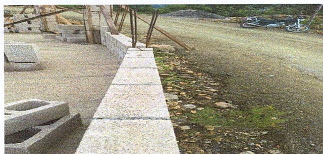
Foto 5:Mejoramiento de tubo hg y malla galvanizada.
