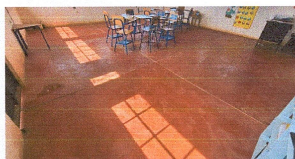
Foto 4: Sustitución de piso de torta de concreto por granito
