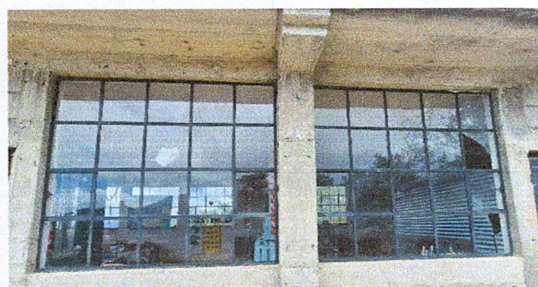
Foto 3: Mejoramiento de balcones de metal.
