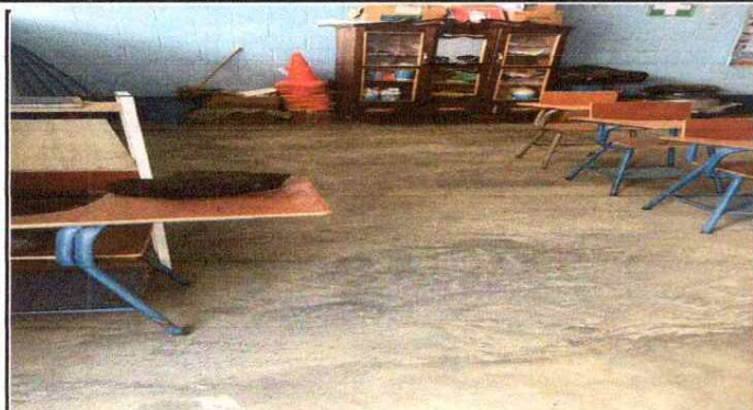
FOTO 1: SUSTITUCION DE PISO DE CEMENTO POR PISO GRANITO
