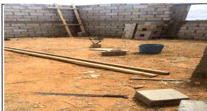
FOTO 5: COLOCACION DE PISO DE CEMENTO
