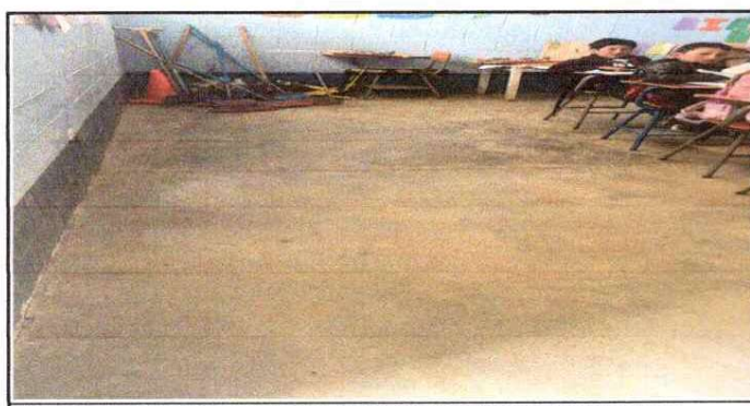
FOTO 5: SUSTITUCION DE PISO DE CEMENTO POR PISO GRANITO
