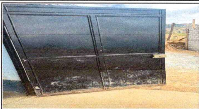
FOTO 2: PINTURA EN PUERTAS DE AULAS
