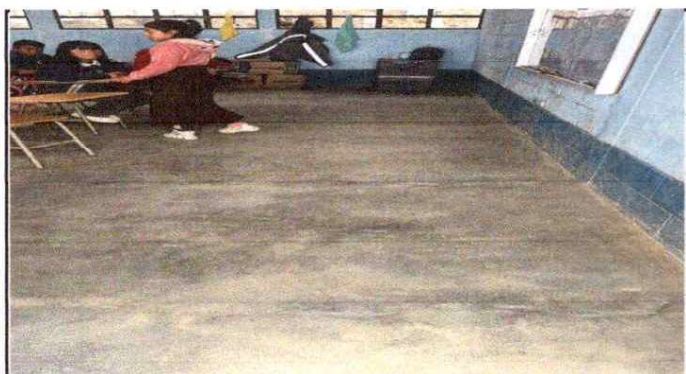
FOTO 3: SUSTITUCION DE PISO DE CEMENTO POR PISO GRANITO
