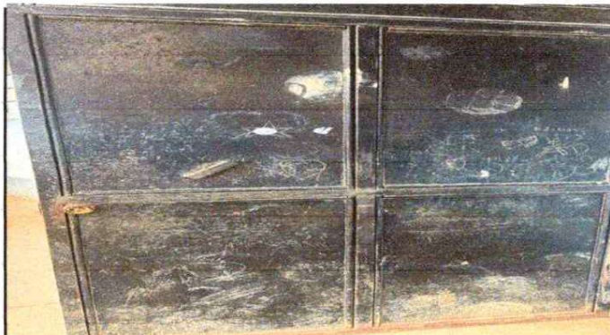
FOTO 4: PINTURA EN PUERTAS DE AULAS
