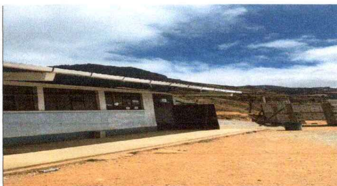
FOTO 6: PINTURA EN PAREDES
