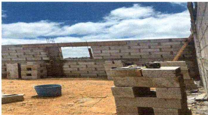
FOTO 4: COLOCACION DE CENTANAS DE METAL
