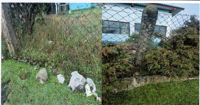
Foto 5: Reparación de tubo hg y malla galvanizada
