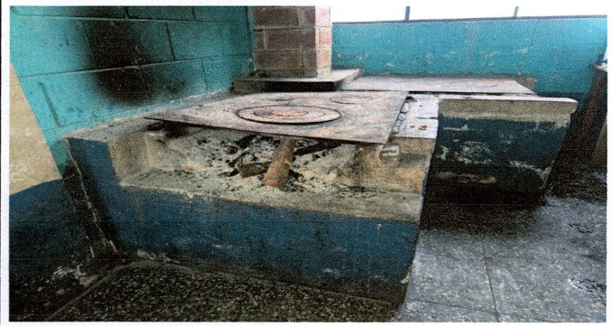
Foto 8: Instalación de azulejo en estufa rural
