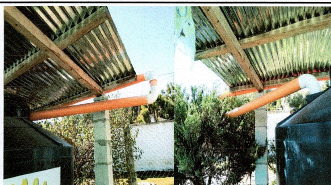
Foto 2: Sustitución de de estructura de soporte de madera por metal
