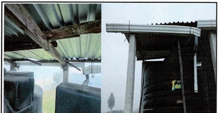
Foto 10: Sustrucción de canal de pvc
