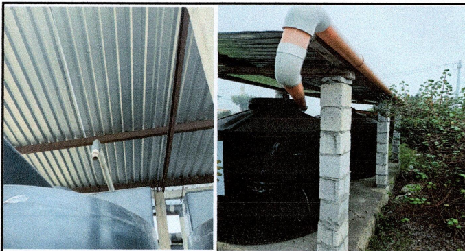
Foto 9: Sustrucción de bajada de agua pluvial, tubo PVC 3"
