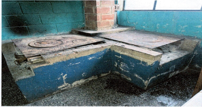
Foto 7: Sustrucción de plancha de metal de 3 hornillas
