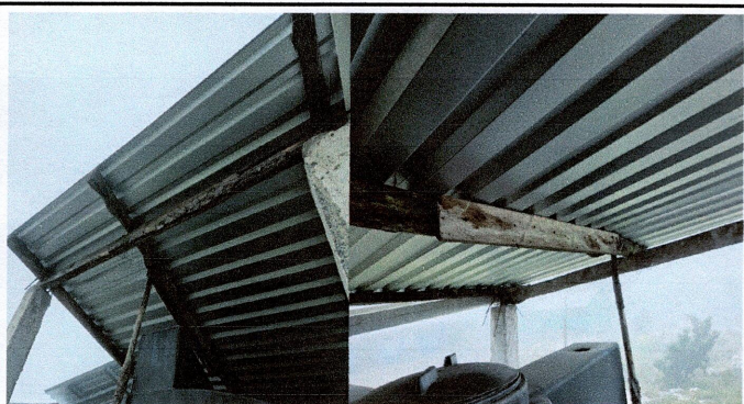
Foto 3: Sustitución de de estructura de soporte de madera por metal
