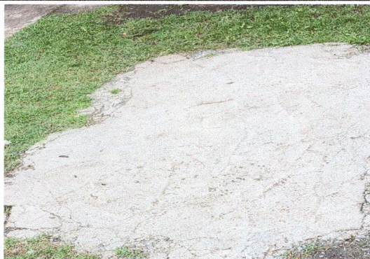
Foto 8: SUSTITUCIÓN DE PLANCHA DE CONCRETO DE PATIO
