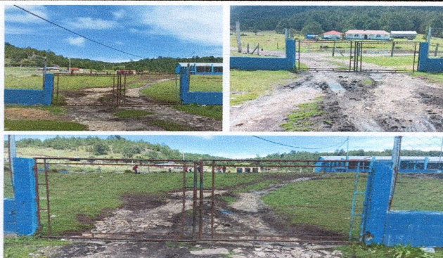
Foto 4: SUSTITUCIÓN DE PORTÓN DE METAL
