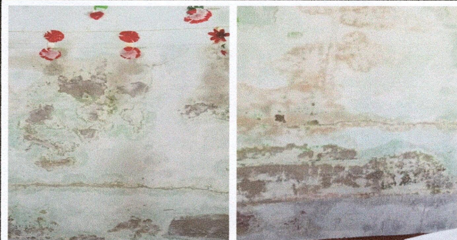
Foto 7: PINTURA EN MUROS EXTERIORES E INTERIORES
