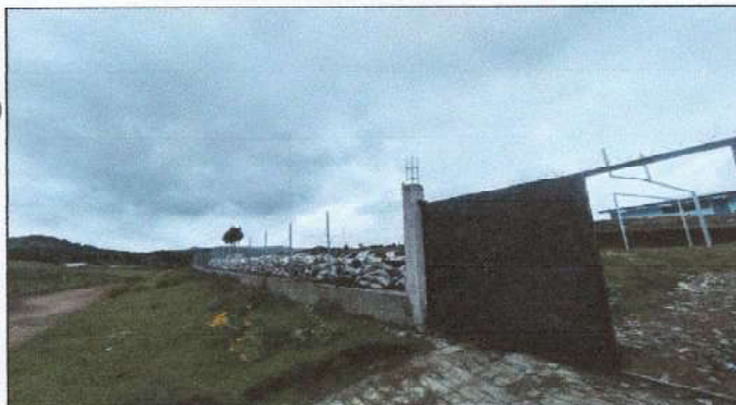
Foto 3: Reparación de muro de contención
