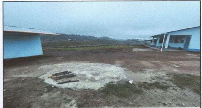
Foto 4: Mejoramiento de planchas de concreto de patio y cuneta
