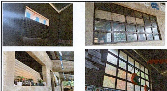
Foto 2: Ventanas: Mejoramiento de estructura de metal de ventana y sustitución de balcones de metal.
