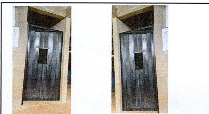
Foto 4: Puertas de metal: Sustitución de puerta (260 x 102)
