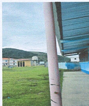
Foto 12: Sustitución de bajadas de agua Pluvial de metal por tubo PVC 3
