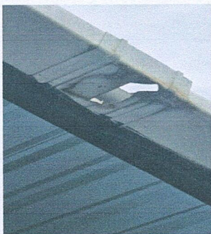
Foto 11: Sustitución de canales de PVC
