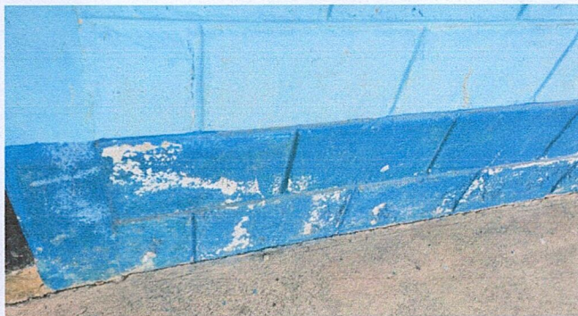
Foto 7: Pintura en muros y exteriores e interiores.
