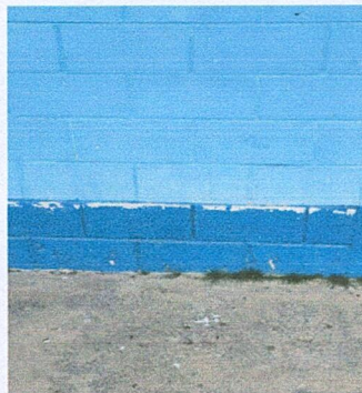
Foto 8: Pintura en muros y exteriores e interiores.
