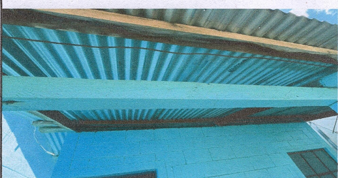
Foto 3: SUSTITUCIÓN DE ESTRUCTURA DE TECHO
