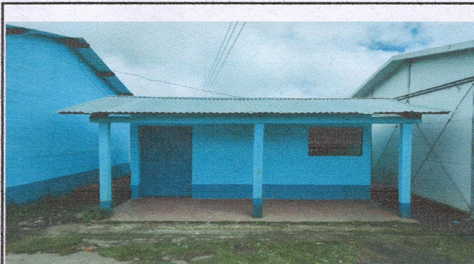
Foto 2: SUSTITUCIÓN DE LÁMINA.
