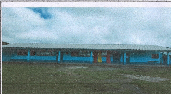
Foto1: SUSTITUCIÓN DE LÁMINA.
