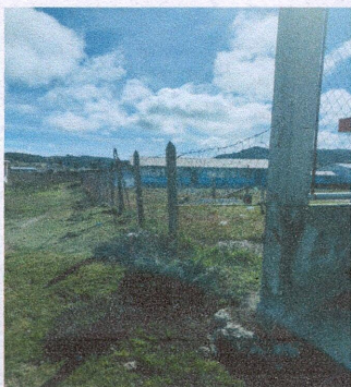
Foto 9: SUSTITUCIÓN DE MURO PERIMETRAL.
