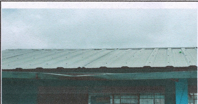
Foto 5: SUSTITUCIÓN DE CANALES Y BAJADAS DE AGUA PLUVIAL
