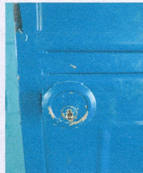
Foto 10: SUSTITUCIÓN DE CHAPA
