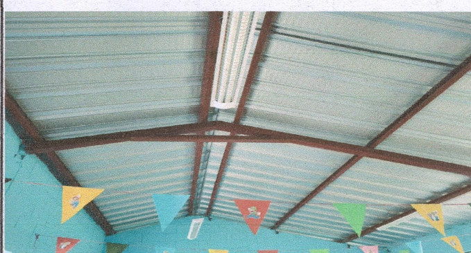
Foto 4: SUSTITUCIÓN DE ESTRUCTURA DE TECHO
