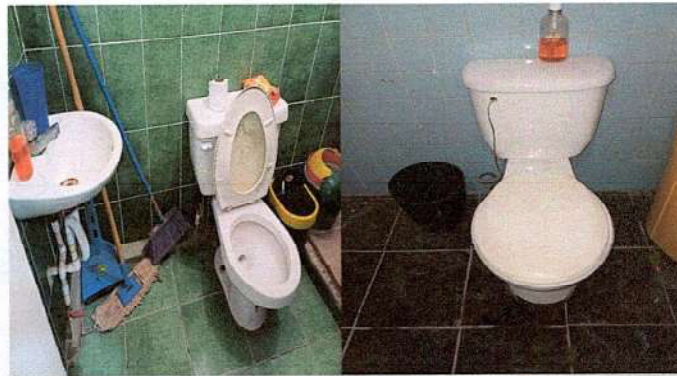
Foto 4: Sustitución de inodoro
