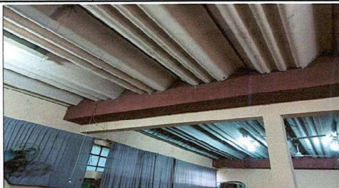
Foto1: Sustitución de lámina de duralita por lámina troquelada calibre 26
