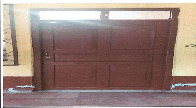
Foto 5: Sustitución de puertas de madera por puertas de metal de 2.45 metros de alto por 1 metro de ancho
