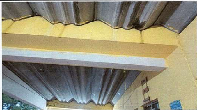
Foto 2: Mejoramiento de Estructura de Techo de metal
