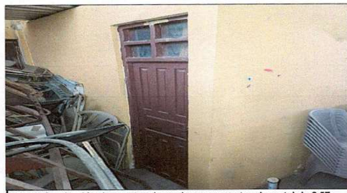
Foto 6: Sustitución de puertas de madera por puertas de metal de 2.57 metros de alto por 72 centímetros de ancho
