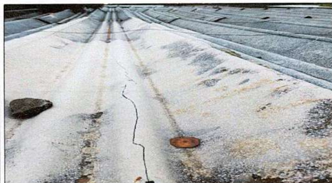
Foto 3: Sustitución de lámina de duralita por lámina troquelada calibre 26
