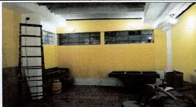
Foto 1: Mejoramiento de mesa de concreto en área de cocina
