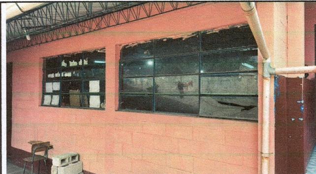
FOTO 6: SUSTITUCIÓN DE VIDRIOS Y PINTURA EN MUROS
