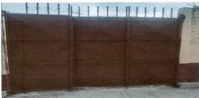
Foto 3: MANTENIMIENTO A PORTÓN
