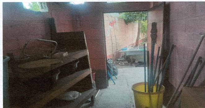
Foto 4: EJORAMIENTO DE COCINA Y SUSTITUCION DE PILA
