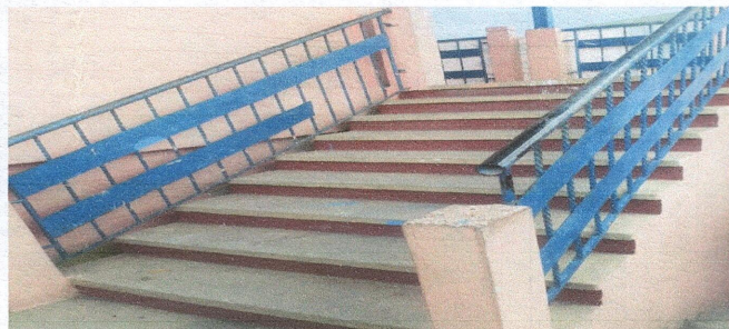
Foto1: MANTENIMIENTO A ESTRUCTURA DE BARANDAS
