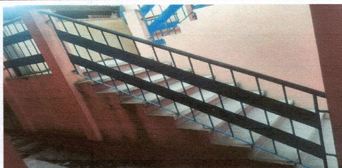
FOTO 6: MANTENIMIENTO A BARANDAS Y PINTURA EN PAREDES DE ESCUELA
