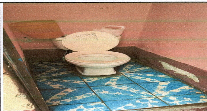
FOTO 3: SUSTITUCION DE INODOROS
