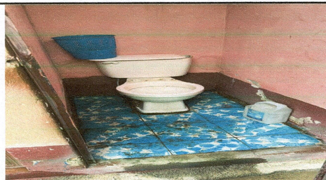
FOTO 4: SUSTITUCION DE INODOROS
