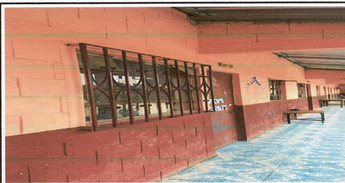
Foto 5: SUSTITUCION DE BALCONES DE METAL
