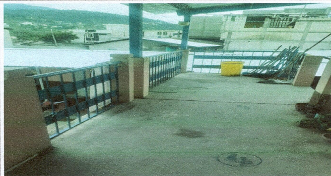
Foto1: MATENIMIENTO A ESTRUCTURA DE BARANDAS
