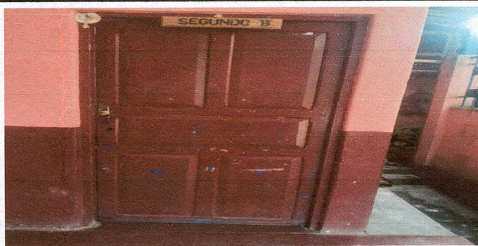
Foto 5: SUSTITUCION DE PUERTA DE MADERA POR METAL
