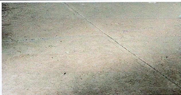
Foto 5: Sustitución de torta de cemento por granito
