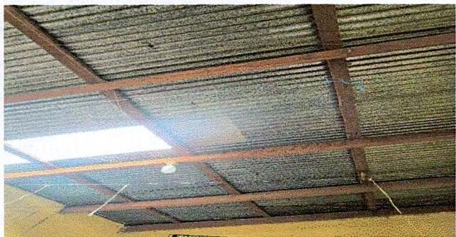
Foto1: Sustitucion cubierta de lamina
