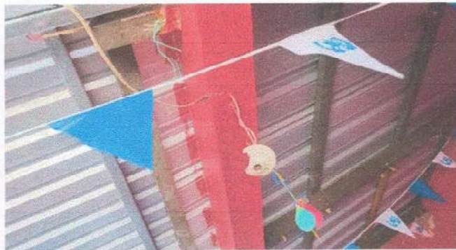
Foto 4: Se cambiara todo el tendido electrico (plafoneras)
