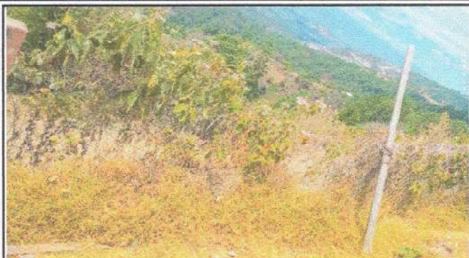
Foto 1: Se colocaran tubos con malla
