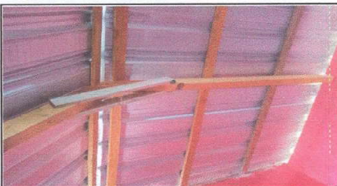
Foto 3: Se instalara energia electrica donde aun no hay
