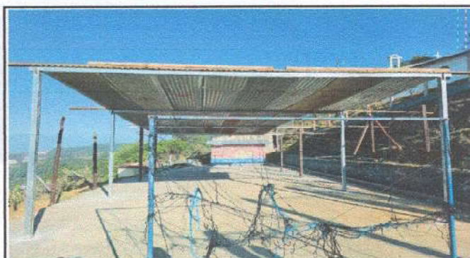
Foto 3: Se instalara energia electrica
