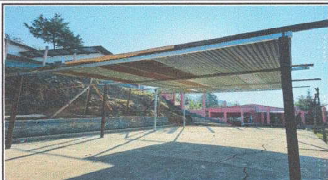
Foto1: Se mejoraran las bases de costaneras
