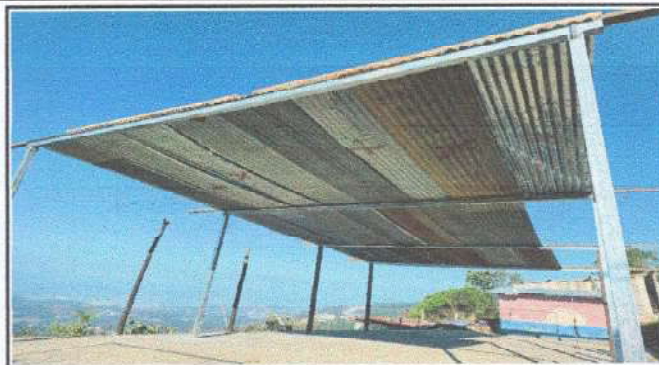
Foto 2: Se cambiara estructura de techo por estructura metalica
