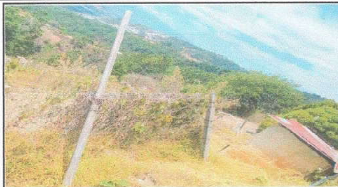
Foto 2: Se susitiuran postes de madera por tubos de metal
