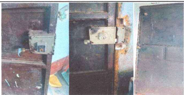
Foto 5: Cambio de Chapas para puerta y aplicación de pintura
