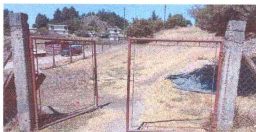
Foto 2: Arreglo de columnas de Portón Principal
