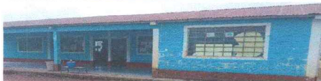
Foto1: Sustitución de lámina por lámina troquelada
