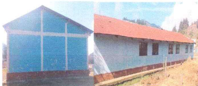
Foto 2: Aplicación de pintura interior y exterior
