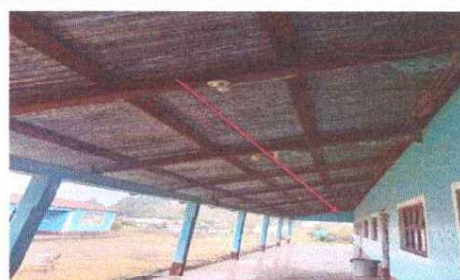
Foto 6: Cambio de Plafoneras
