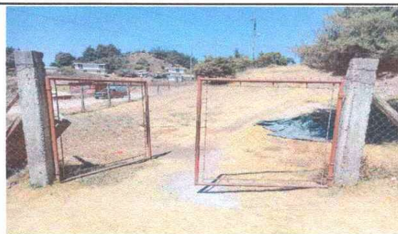
Foto 6: Sustitución de Portón principal
