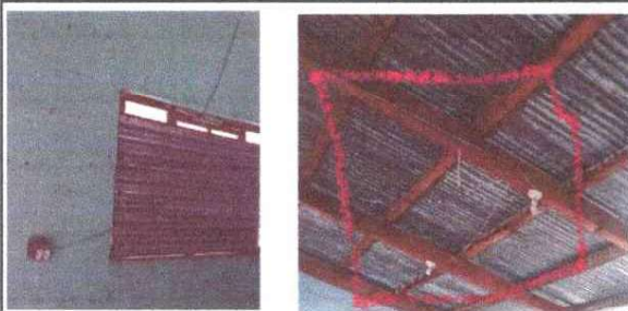
Foto 5: CAMBIO DE CABLE SÓLIDO
