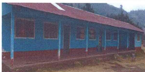
Foto1: Sustitución de Ventanas de madera por ventanas de metal
