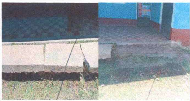
Foto 4: Mejoramiento y sustitución de Banqueta de cemento
