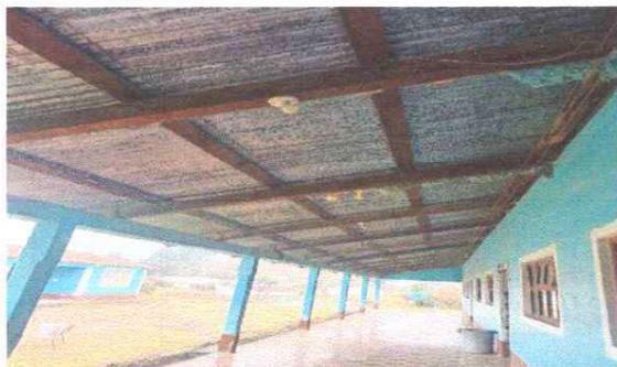
Foto 3: Sustitución de Estructura portante
