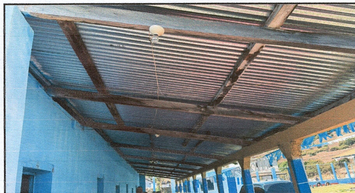
FOTO 3: SUSTITUCION DE ESTRUCTURA
