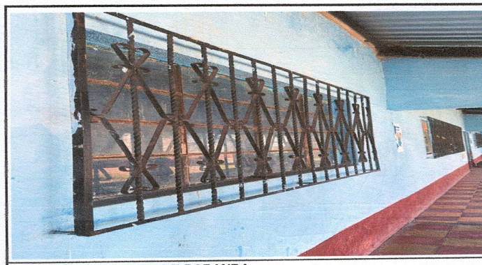
FOTO 6: SUSTITUCION DE BARANDA
