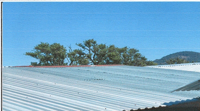
FOTO 2: SUSTITUCION DE CAPOTE
