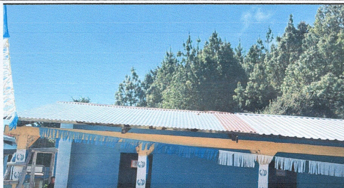
FOTO 1: SUSTITUCION DE LAMINA
