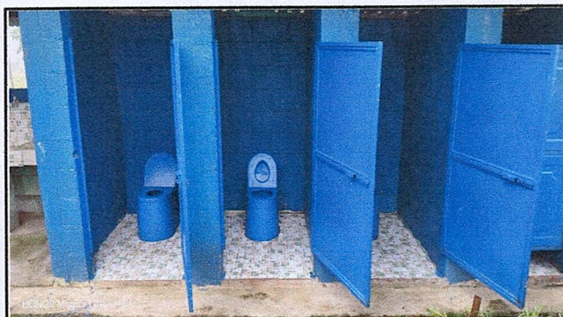
FOTO 4: SUSTITUCION POR SANITARIOS
