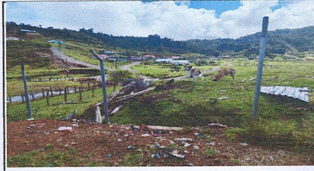
FOTO 10: REPARACION DE TUBO HG Y MALLA GALVANIZADA
