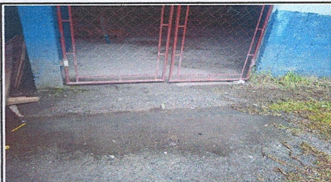
FOTO 13: SUSTITUCION DE LOSA DE ENTRADA DEL SALON
