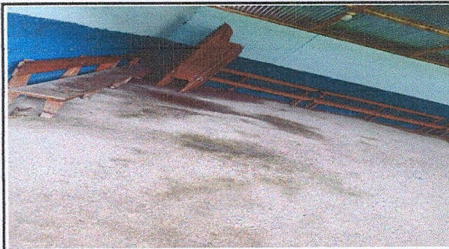
FOTO 8: TORTA DE CEMENTO POR GRANITO
