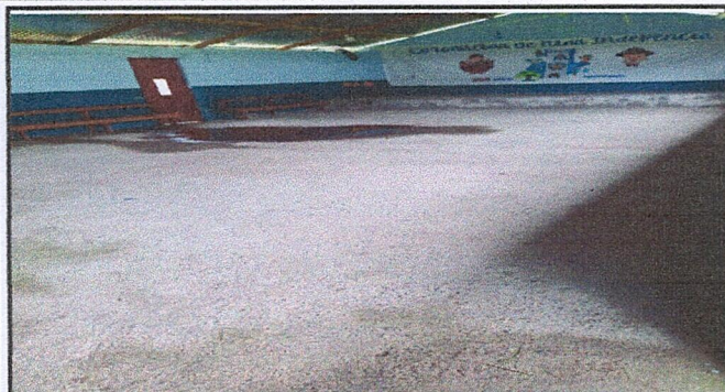
FOTO 7: TORTA DE CEMENTO POR GRANITO
