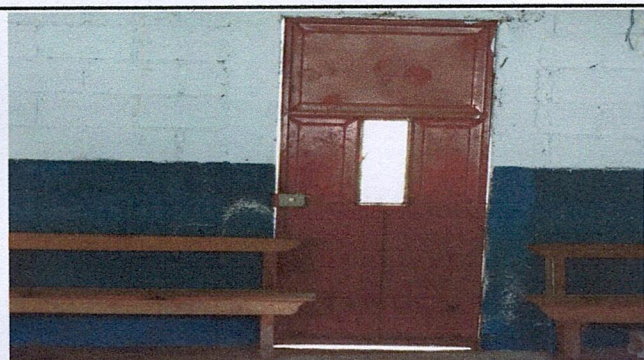
FOTO 3: MANTENIMIENTO DE PUERTA DE SALON
