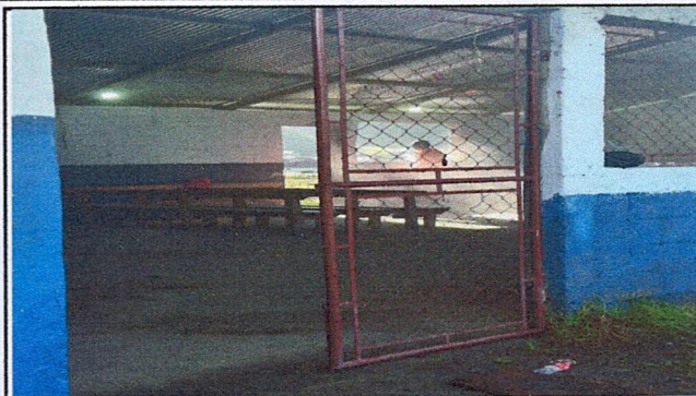
FOTO 2: SUSTITUCION DE PUERTON DE SALON
