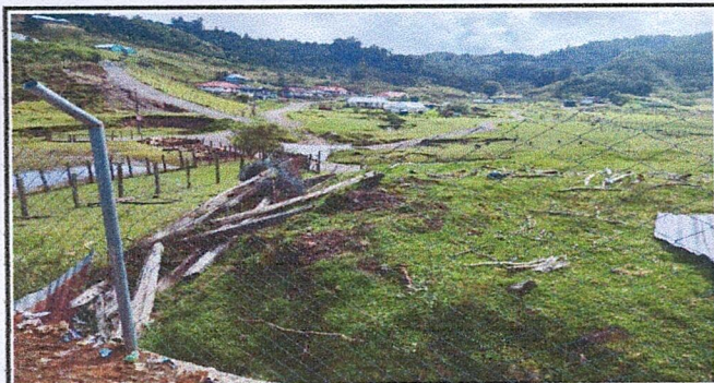
FOTO 9: REPARACION DE TUBO HG Y MALLA GALVANIZADA
