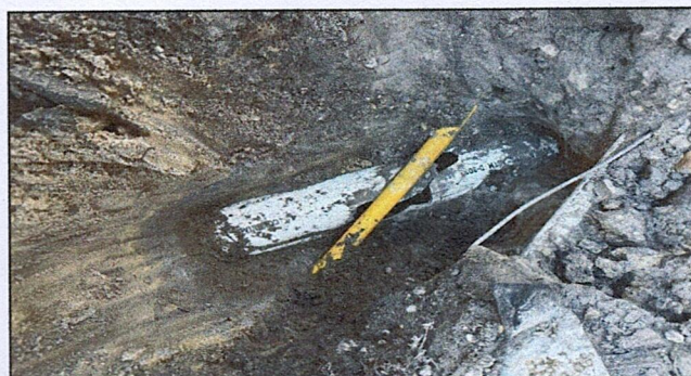
FOTO 6: SUSTITUCION DE TUBERIA PVC LINEA PRINCIPAL AGUAS NEGRAS Y PLUVIALES.
