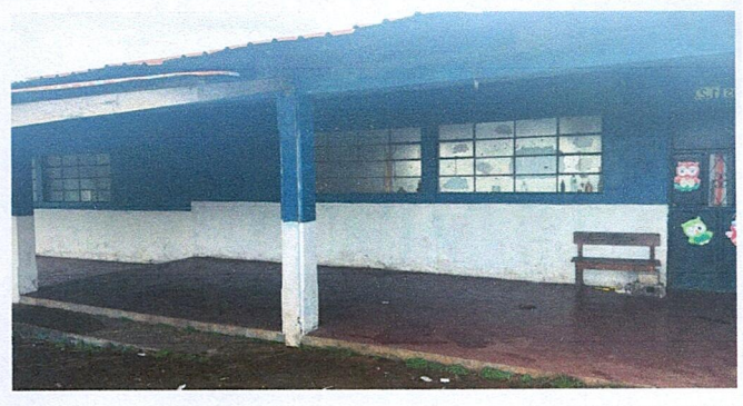
FOTO 4: Pintura en paredes
