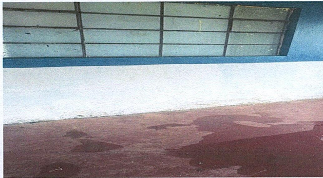
FOTO 3: Pintura en paredes
