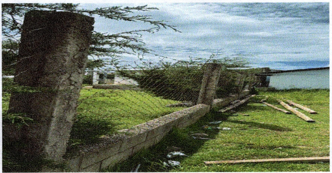
Foto 5: Sustitucion de tubo hg y malla galvanizada
