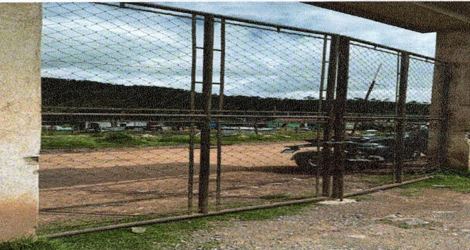
Foto 6: Sustitución de portón de metal
