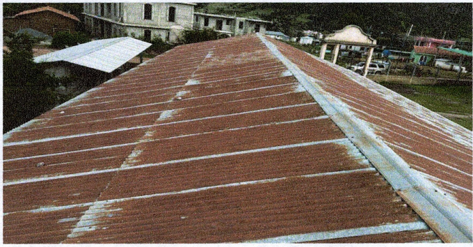
Foto1: Sustitución de cubierta de lámina
