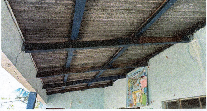
Foto2: Sustitución de estructura de madera por metal
