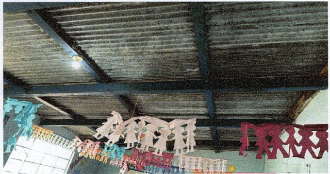
Foto 3: Sustitución de estructura de madera por metal
