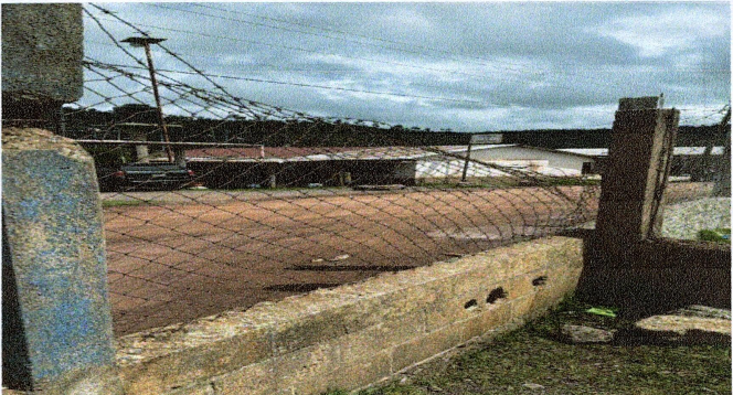
Foto 4: Sustitucion de tubo hg y malla galvanizada
