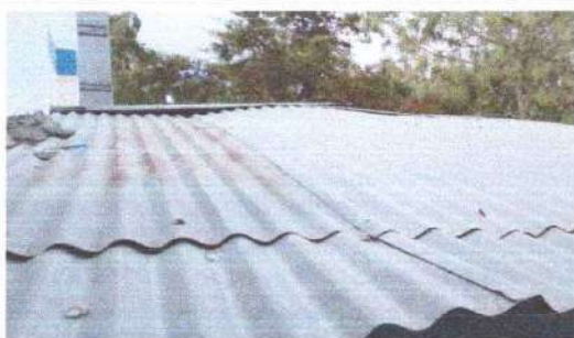
Foto 5: Sustitución de lámina
