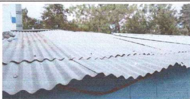
Foto 1: Estructura metálica y cubierta de lámina
