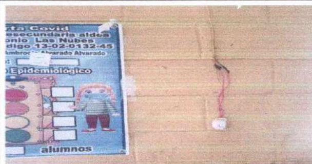
Foto 6: Reparación del sistema eléctrico
