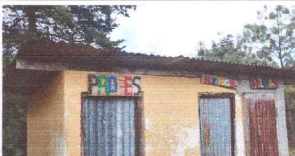
Foto 4: Puertas de metal
