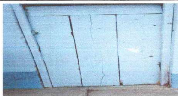
Foto 5: Puerta de metal
