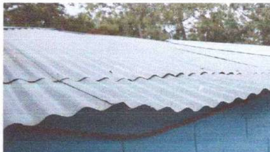
Foto 6: Sustitución de lámina
