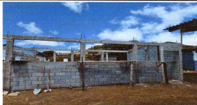
Foto 4: Mejoramiento de estructura de metal de ventana
