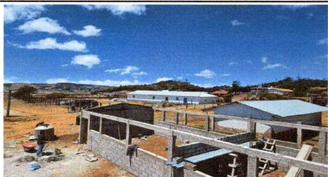
Foto 1: Mejoramiento de lámina troquelada aluzinc calibre 26
