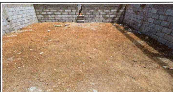
Foto 5: Mejoramiento de piso de granito
