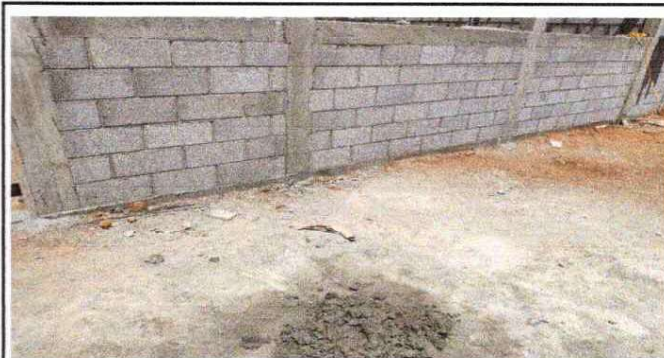
Foto 8: Mejoramiento de Cuneta de concreto
