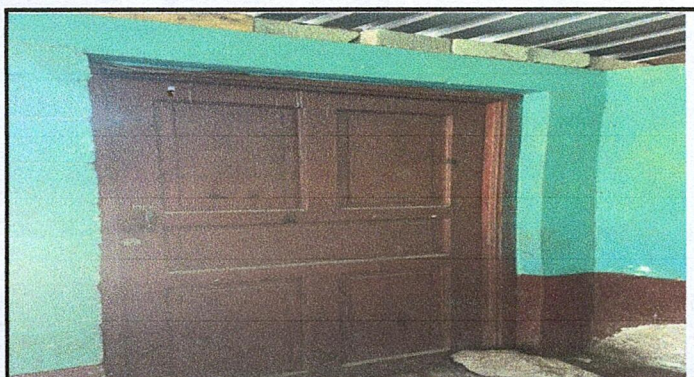
foto 3: cambio de puerta de madera por metal
