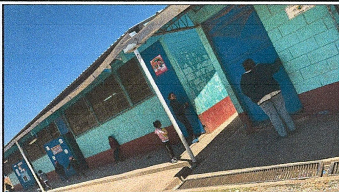
foto 1: pintura de paredes exteriores
