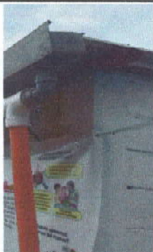
Foto 25: Sustrucción de bajada de agua pluvial, tubo blanco de 3 pulgadas
