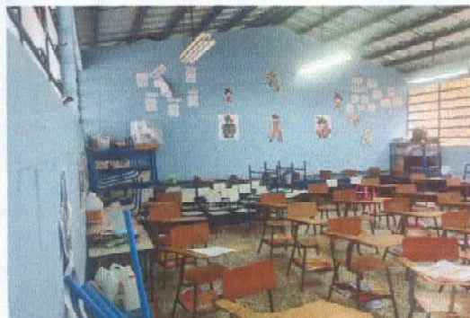
Foto 14: Aplicación de pintura interior y exterior
