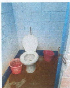
Foto 21: Sustrucción de inodoros
