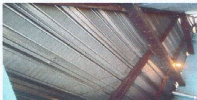
Foto 2: Sustrucción de estructura portante de madera por metalica. Cocina.
