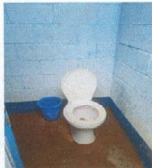
Foto 22: Sustrucción de inodoros
