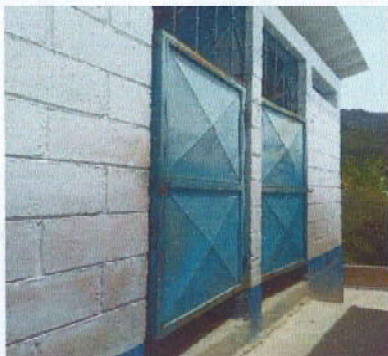
Foto 19: Sustrucción Puertas de baños de 1.60 metros de alto por 0.81 metros de ancho
