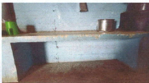
Foto 3: Mejoramiento Puertas para gabinetes de cocina de 1.51 de ancho por 0.65 de alto
