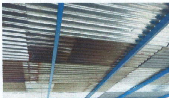
Foto 16: Sustitución de lamina por lamina Maxalum C26
