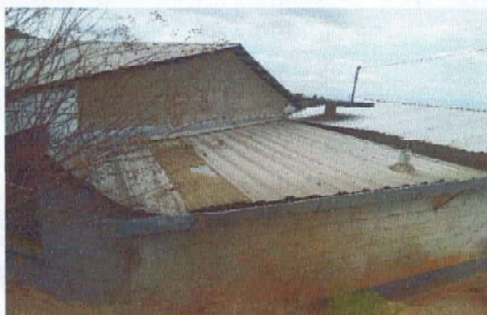
Foto1: Sustrucción de lamina por lamina Maxalum. Cocina.
