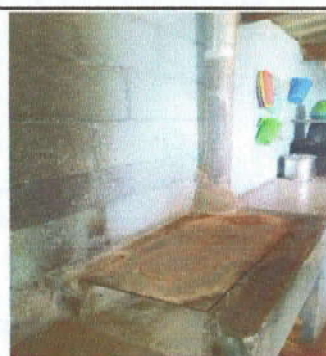
Foto 12: Sustrucción de plancha de metal de 3 hornillas 1/4
