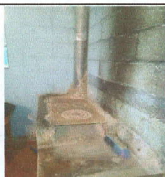
Foto 11: Sustrucción de plancha de metal de 3 hornillas 1/4
