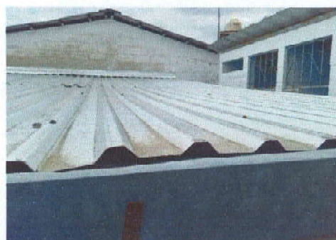
Foto 28: Sustrucción de lamina por lamina Maxalum. AULA.
