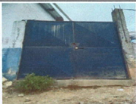
Foto 9: Sustrucción Porton de metal de 2 hojas con lamina encajelada de 2.10 m de alto X 1.93 m de ancho
