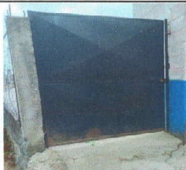
Foto 10: Sustrucción Porton de metal de 2 hojas con lamina encajelada de 2.00 m de alto X 1.52 m de ancho
