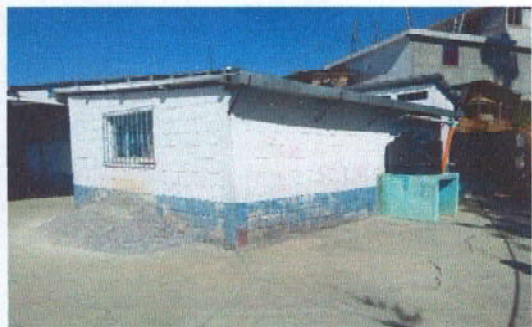
Foto13: Aplicación de pintura interior y exterior
