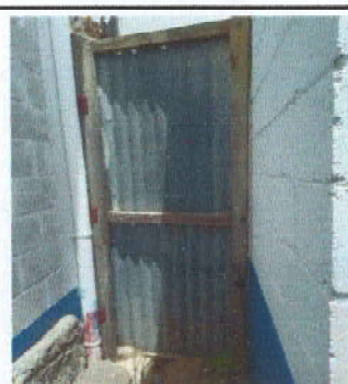
Foto 18: Sustitución Puerta de metal de 2.35 metros de alto por 1 metro de ancho
