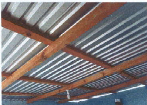
Foto 27: Sustrucción de estructura portante de madera por metalica. AULA.
