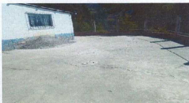
Foto 15: Sustitución de piso de concreto por piso de concreto
