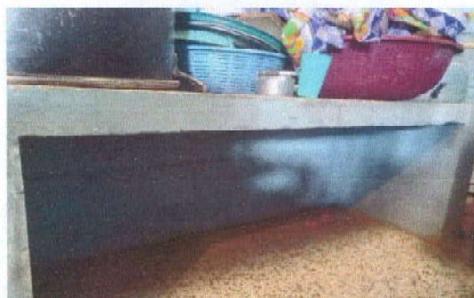
Foto 4: Mejoramiento Puertas para gabinetes de cocina de 1.51 de ancho por 0.65 de alto
