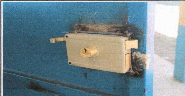
Foto 6: REGLON: SUSTITUCIÓN DE CHAPA
