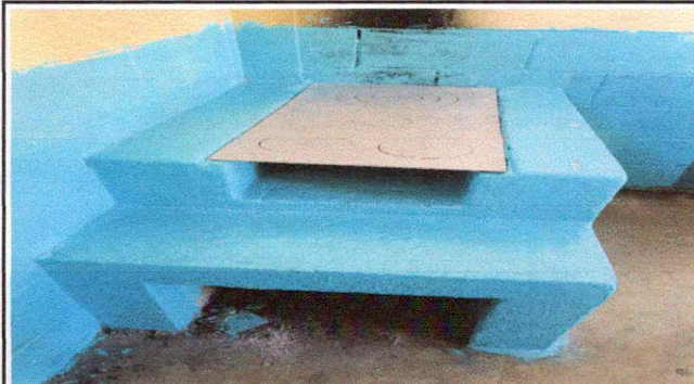
Foto 14: RENGLO: REPARACION DE COCINA
