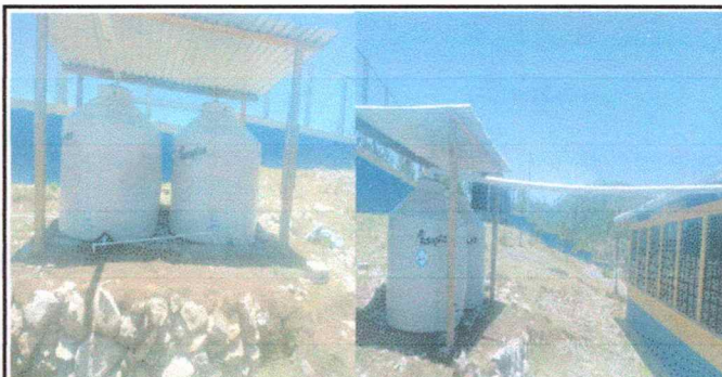
Foto 10: SUSTITUCIÓN DE DEPOSITO DE AGUA
