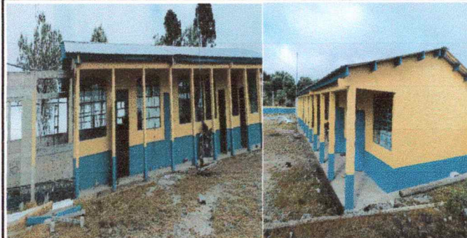
Foto 8: RENGLON: PINTURA EN MUROS EXTERIORES E INTERIORES
