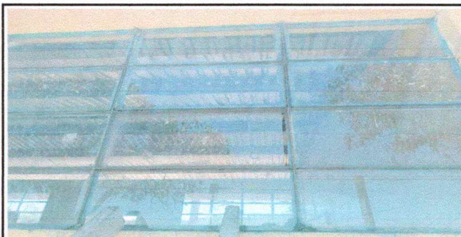
Foto 12: SUSTITUCIÓN DE VIDRIOS
