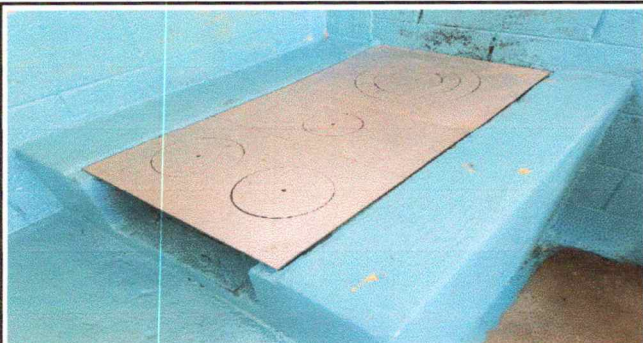
Foto 13: RENGLO: REPARACION DE COCINA
