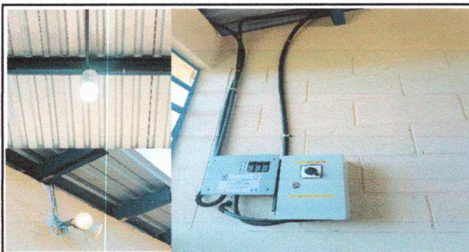
Foto 9: RENGLON: REPARACION DEL SISTEMA ELECTRICO
