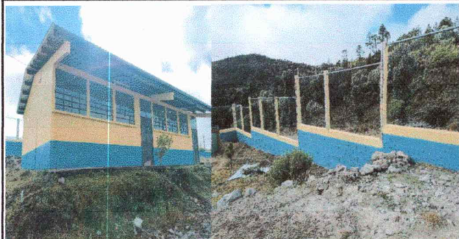
Foto 7: RENGLON: PINTURA EN MUROS EXTERIORES E INTERIORES
