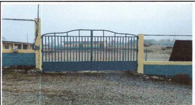
Foto 3: REGLON: PUERTAS DE METAL. PORTON No. 1 (parte principal )
