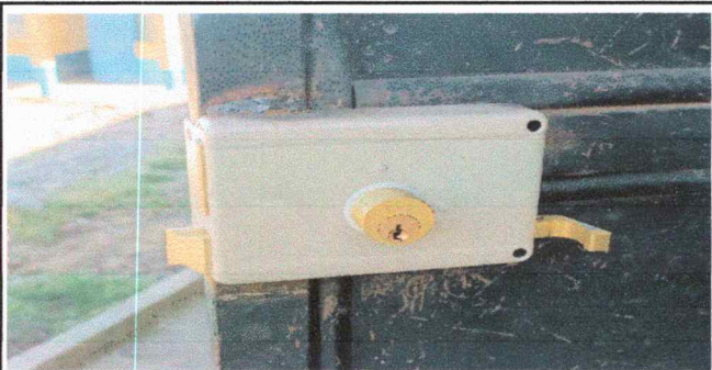
Foto 5: REGLON: SUSTITUCIÓN DE CHAPA
