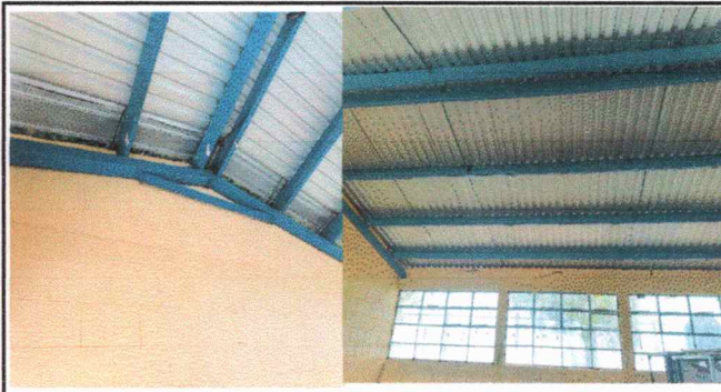
Foto 2: REGLON: ESTRUCTURA DE TECHO
