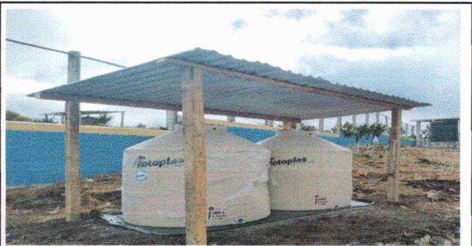
Foto 10: SUSTITUCIÓN DE DEPOSITO DE AGUA
