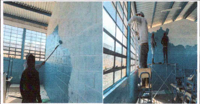
Foto 8: RENGLON: PINTURA EN MUROS EXTERIORES E INTERIORES
