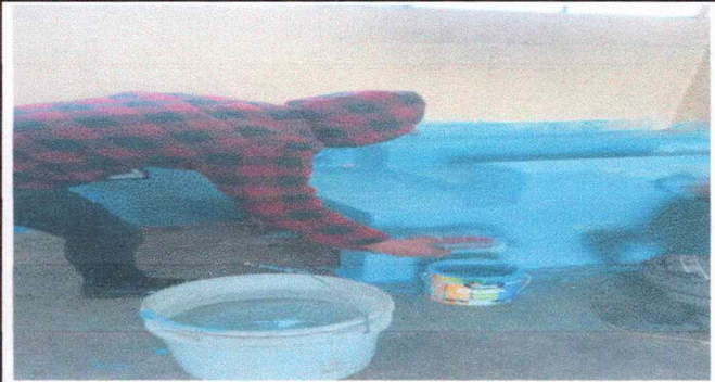
Foto 14: RENGLO: REPARACION DE COCINA
