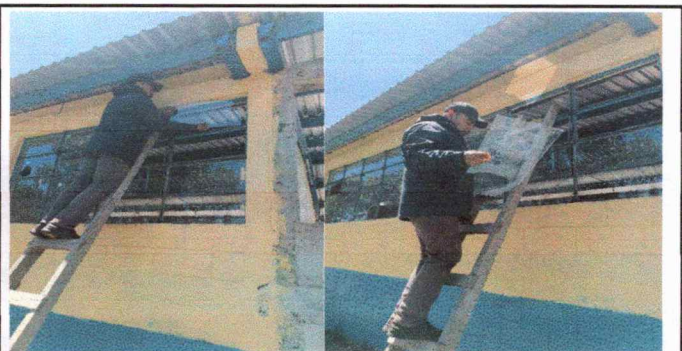
Foto 12: SUSTITUCIÓN DE VIDRIOS
