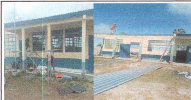
Foto1: RENGLON: CUBIERTA DE LAMINA
