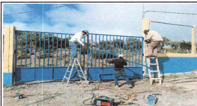
Foto 3: RENGLON: PUERTAS DE METAL. PORTON No. 1 (parte principal )
