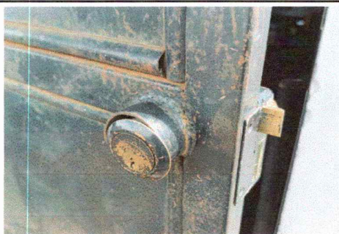
Foto 5: RENGLON: SUSTITUCIÓN DE CHAPA
