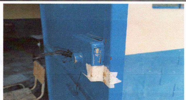
Foto 6: RENGLON: SUSTITUCIÓN DE CHAPA
