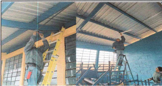
Foto 9: RENGLON: REPARACION DEL SISTEMA ELECTRICO
