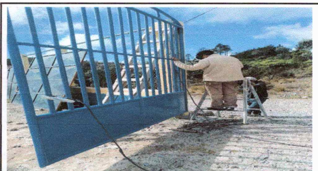
Foto 4: RENGLON: PUERTAS DE METAL.
