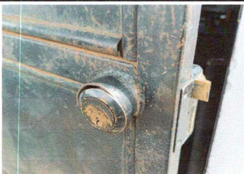
Foto 5: RENGLON: SUSTITUCIÓN DE CHAPA
