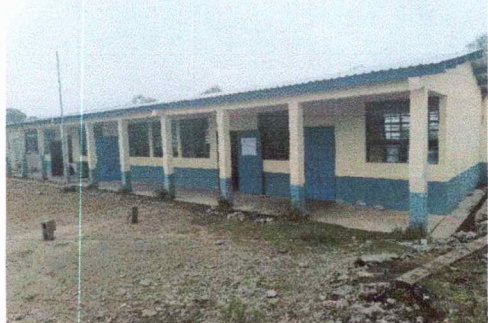
Foto 7: RENGLON: PINTURA EN MUROS EXTERIORES E INTERIORES
