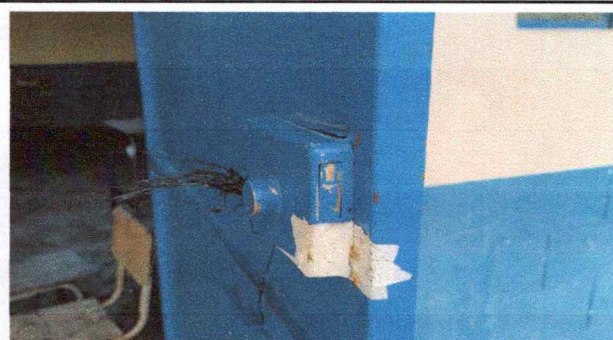
Foto 6: RENGLON: SUSTITUCIÓN DE CHAPA
