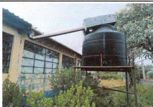
Foto 10: SUSTITUCIÓN DE DEPOSITO DE AGUA
