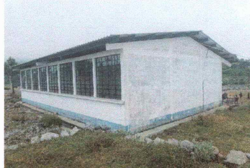
Foto 8: RENGLON: PINTURA EN MUROS EXTERIORES E INTERIORES
