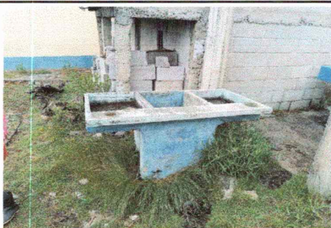
Foto 11: SUSTITUCIÓN DE PILA
