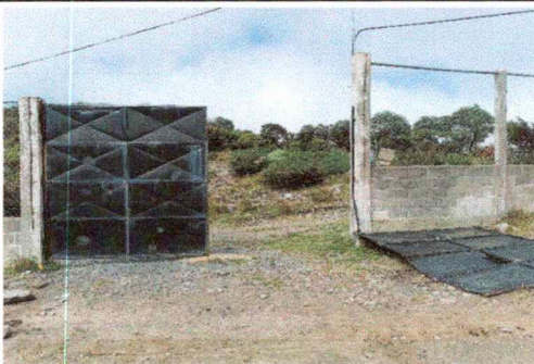
Foto 3: RENGLON: PUERTAS DE METAL. PORTON No. 1 (parte principal )
