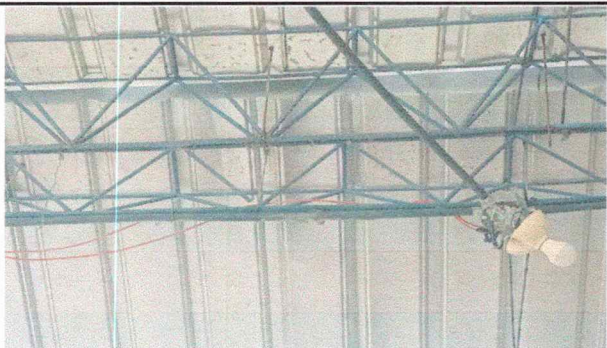
Foto 9: RENGLON: REPARACION DEL SISTEMA ELECTRICO
