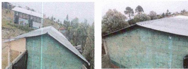
Foto1: RENGLON: CUBIERTA DE LAMINA
