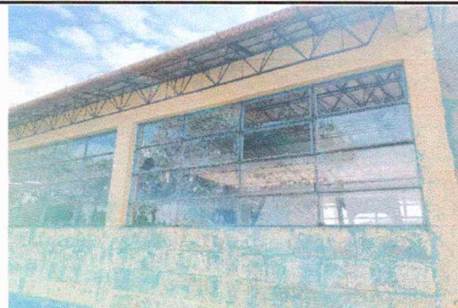
Foto 12: SUSTITUCIÓN DE VIDRIOS
