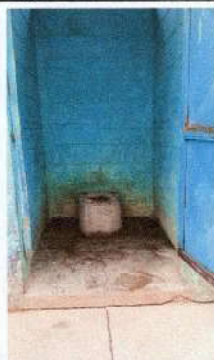
Foto 3: SUSTITUCION DE LOSA POR AZULEJO
