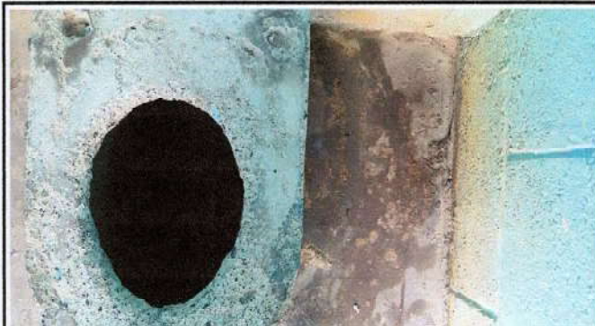
Foto 2: SUSTITUCION DE LETRINAS
