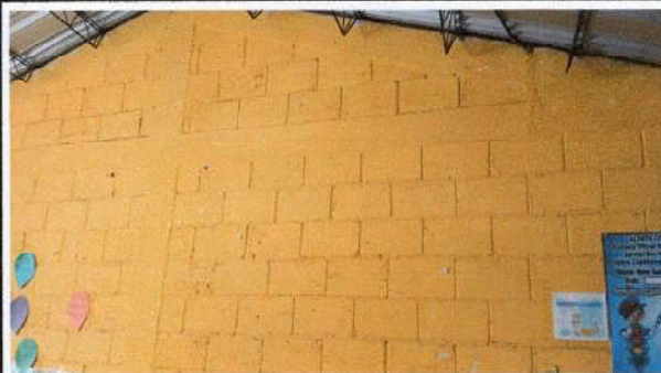
Foto 4: PINTAR MUROS EXTERIORES E INTERIORES
