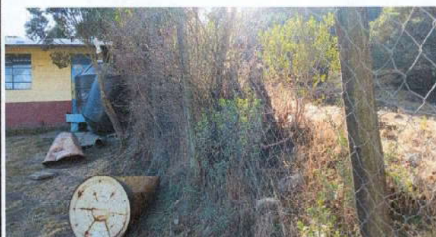
Foto 4: CERCO PERIMETRAL INCLINADO
