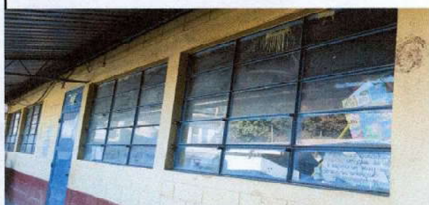
Foto 3: mejoramiento de balcones
