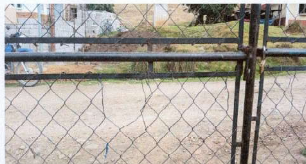
Foto 2: MEJORAMIENTO DE PORTON
