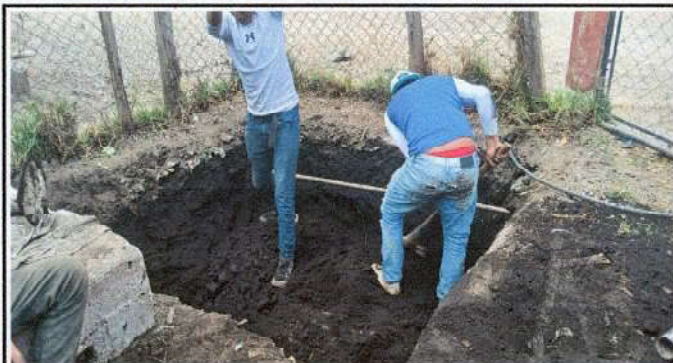
Foto1: TRABAJOS EN POZO DE ABSORCIÓN
