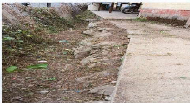
Foto 3: MURO DE CONTENCION INFORMAL
