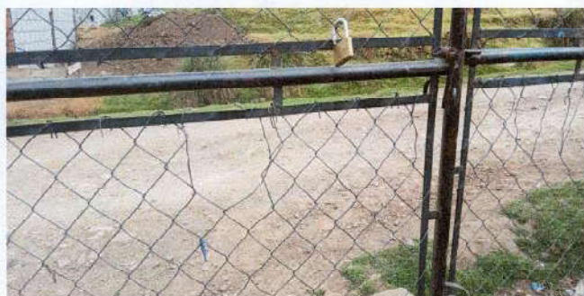
Foto1: SUSTITUCION DE MALLA
