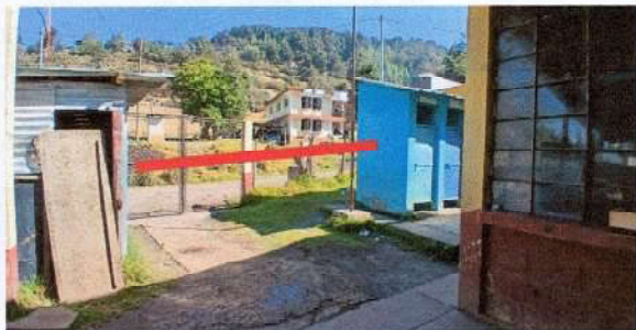
Foto 5: DISTANCIA ENTRE BAÑOS Y CISTERNA
