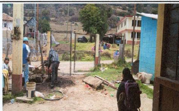
Foto 2: UBICACIÓN DE POZO DE ABSORCIÓN
