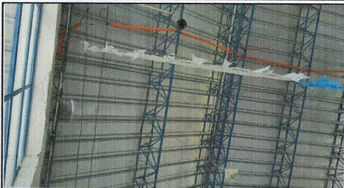
Foto 1: CUBIERTA DE LAMINA
