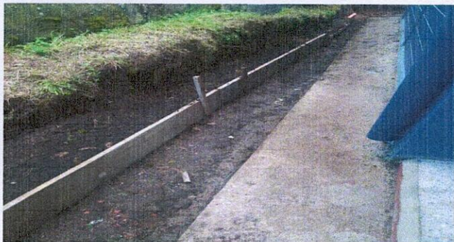
Foto 7: RED DE AGUA POTABLE
