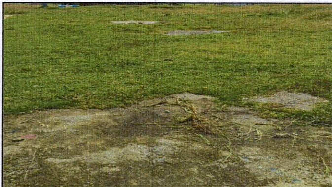
Foto 8: LOSA DE PATIO
