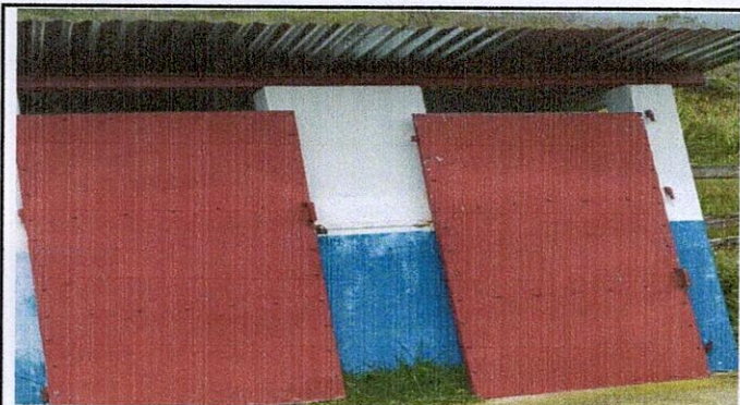
Foto 3: PUERTAS DE METAL
