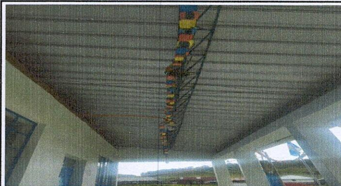
Foto 2: ESTRUCTURA DE TECHO
