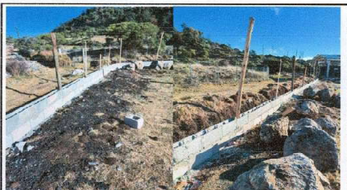
Foto 3: Reparación de muro perimetral con tubo hg y malla galvanizada ✓
