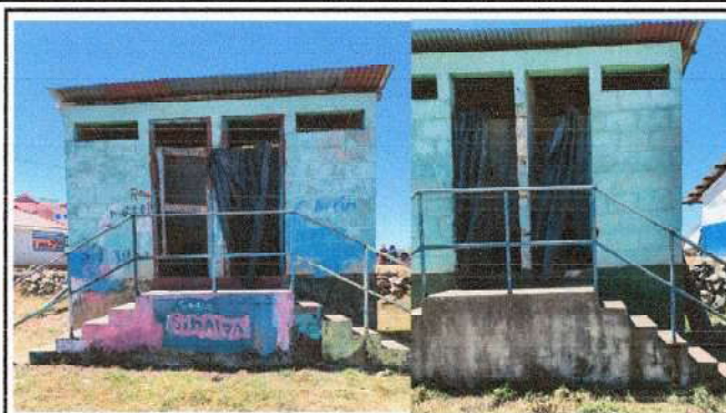
Foto 2: Mejoramiento de puertas de metal de servicios sanitarios ✓
