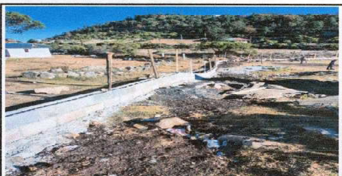
Foto 5: Reparación de muro perimetral con tubo hg y malla galvanizada ✓
