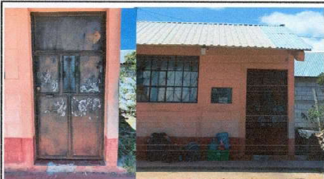
Foto 3: Mantenimiento a estructura de puertas de metal de aulas (incluye lijado, cepillado y aplicación de pintura) ✓
