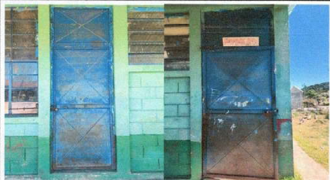
Foto 1: Mantenimiento a estructura de puertas de metal de aulas (incluye lijado, cepillado y aplicación de pintura) ✓
