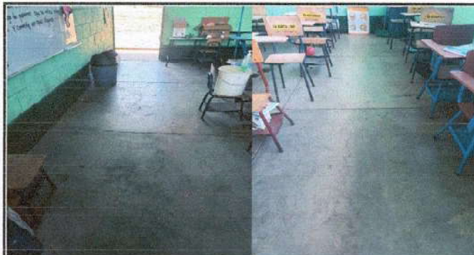
Foto 4: Sustitución de piso de tortaa de concreto por piso granito ✓
