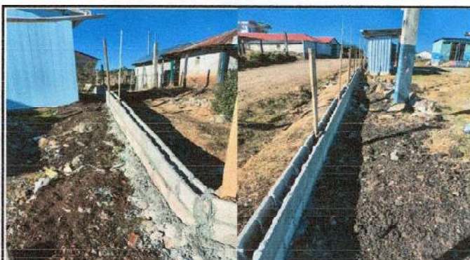
Foto 4: Reparación de muro perimetral con tubo hg y malla galvanizada ✓
