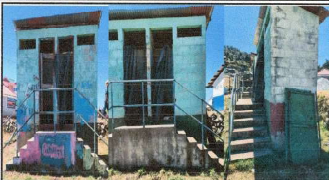
Foto1: Pintura de muros exteriores e interiores de servicios sanitarios ✓
