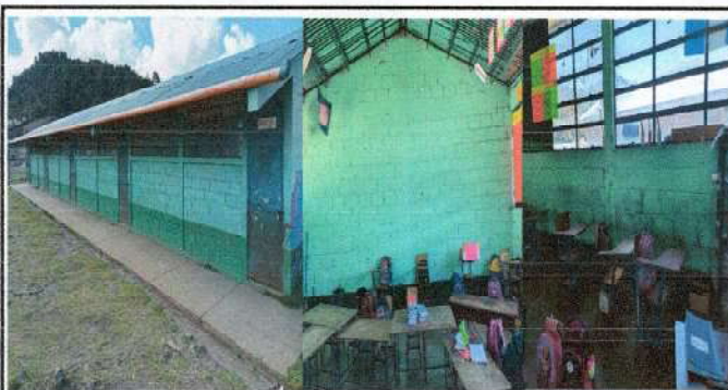
Foto 5: Pintura de muros exteriores e interiores ✓
