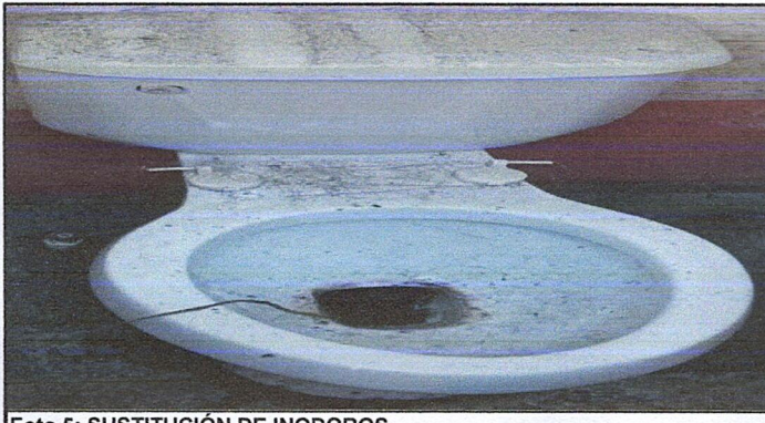
Foto 5: SUSTITUCIÓN DE INODOROS
