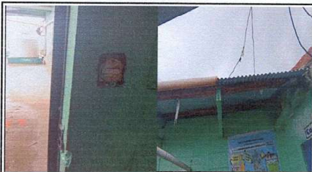
Foto 9: Reparación del sistema eléctrico
