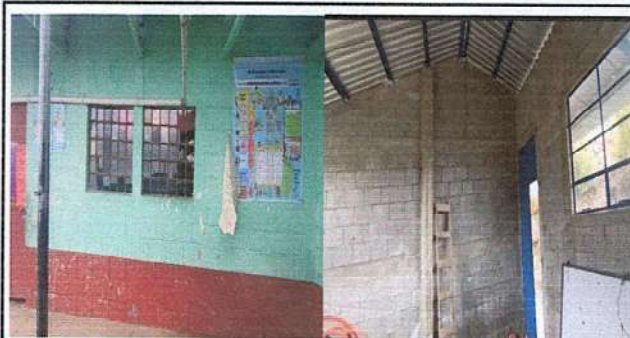
Foto 6: Pintura de muros exteriores e interiores
