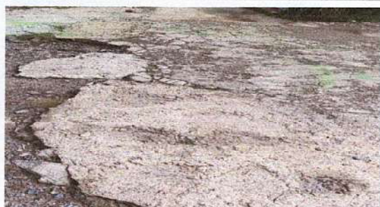
Foto 7: Sustrucción de planchas de concreto del patio
