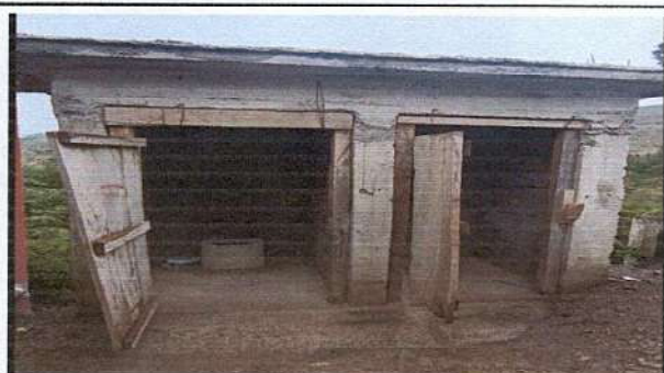
Foto 3: Sustrucción de puertas de madera por metal de 1.80 metros de alto por 0.80 metros de ancho
