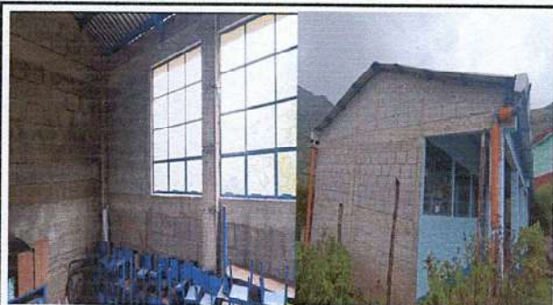
Foto 11: Mejoramiento de repello de muros
