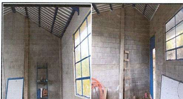
Foto 10: Repello de muros
