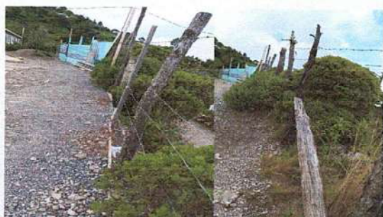
Foto5: Reparación de tubo hg y malla galvanizada
