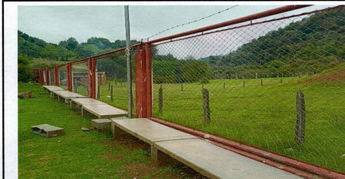
Foto 5: Sustitución de malla galvanizada por electromalla de cuadro de 4 por 4 pulgadas y 1/4 de grosor
