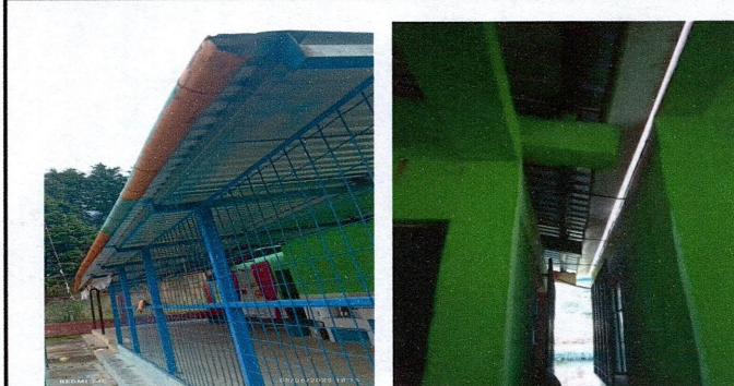
Foto 2: Sustitución de soportes de canal de metal.
