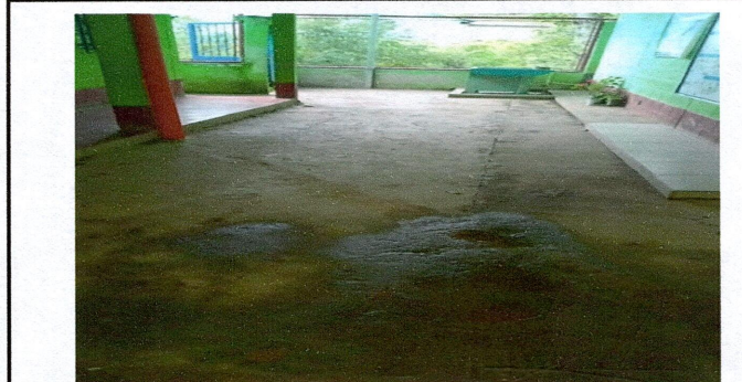
Foto 6: Sustitución de planchas de concreto del patio
