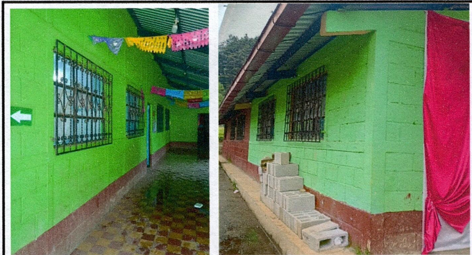
Foto 3: Pintura de muros exteriores e interiores
