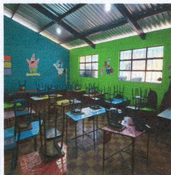
Foto1: Repello de muros
