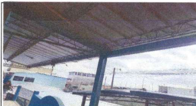
TECHO SEGUNDO NIVEL: Complemento derivado de que lluvia cae sobre ubicación de cisterna y pilas
