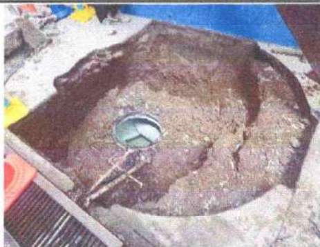
Foto 1: Mejoramiento cisterna y piso del corredor donde se ubica la cisterna, en cisterna se realizarán sustitución de la cisterna y mejoramiento del espacio para ubicarla de 16 metros cubicos, así mismo las mejoras en el sistema eléctrico, respecto al corredor se mejorará colocando piso de granito.
