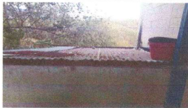
COCINA: Sustitucion de lamina por lamina y estrucutra portante .
