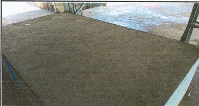
Foto 3: REPARACIÓN PLANCHAS DE CONCRETO DE ESCENARIO
