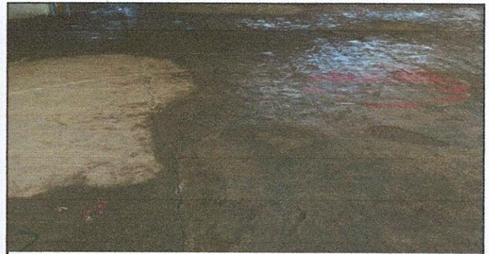
Foto 2: REPARACIÓN DE PLANCHAS DE CONCRETO DE PATIO
