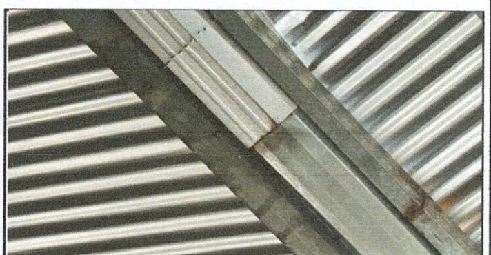
Foto 6: SUSTITUCIÓN DE CANAL DE PVC
