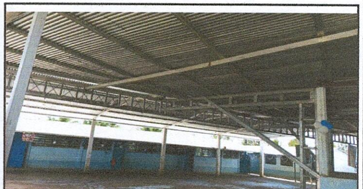
Foto 4: REPARACIÓN DE SISTEMA ELÉCTRICO CANCHA
