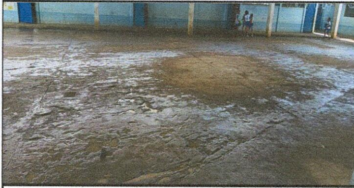
Foto 1: REPARACIÓN DE PLANCHAS DE CONCRETO DE PATIO
