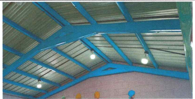
Foto 12: Sustitución de lámparas tipo led.
