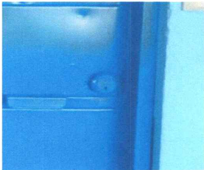
Foto 3: Sustitución de chapa
