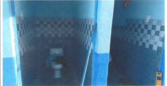
Foto 8: Instalación de azulejo
