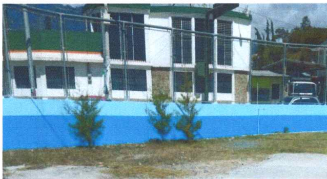
Foto 11: Cernido en muros
