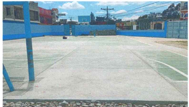
Foto 4: Sustitución de plancha de concreto.
