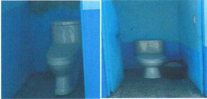
Foto 7: Sustitución de inodoro
