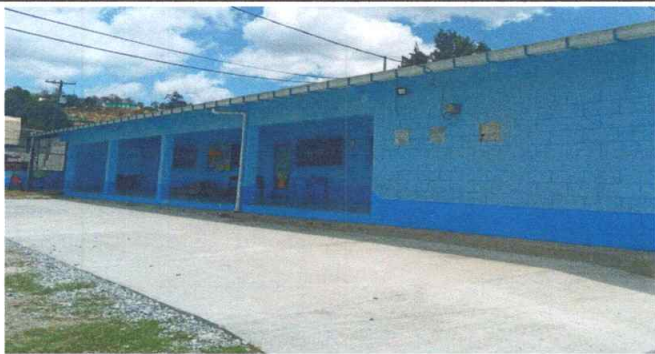
Foto 5: Reparación de plancha de concreto
