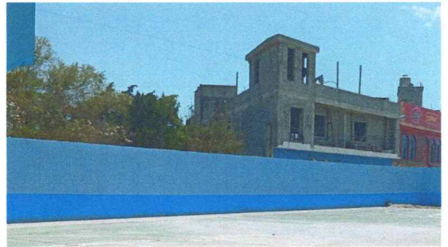
Foto 10: Repello de muro.
