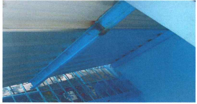
Foto2: Sustitución de estructura de soporte de metal.
