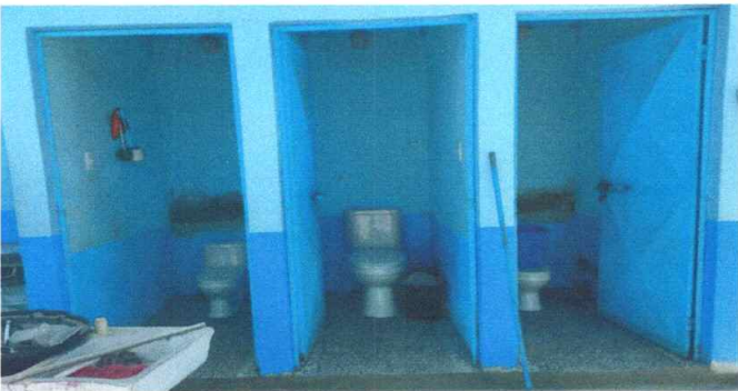
Foto 9: Instalación de piso de granito.
