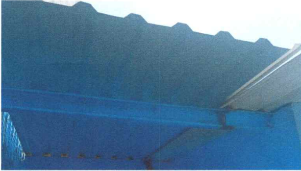
Foto1: Sustitución de lámina por lámina troquelada.
