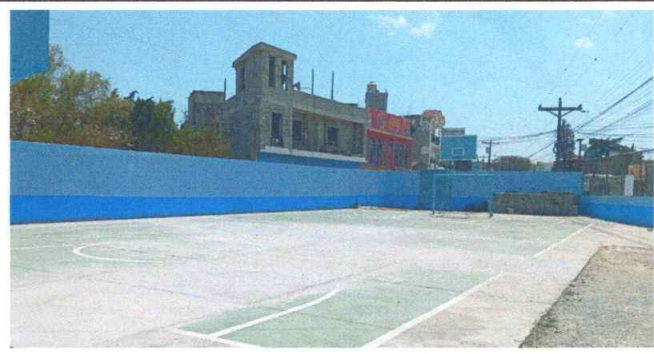
Foto 6: Aplicación de pintura en muro
