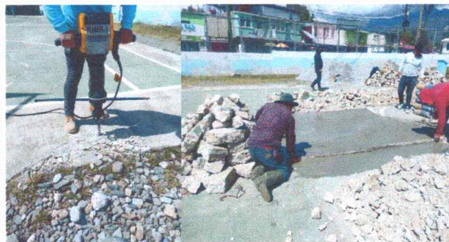
Foto 4: Sustitución de plancha de concreto.
