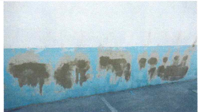
Foto 10: Repello de muro.
