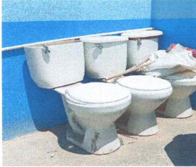
Foto 7: Sustitución de inodoro
