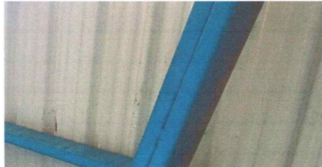
Foto2: Sustitución de estructura de soporte de metal.
