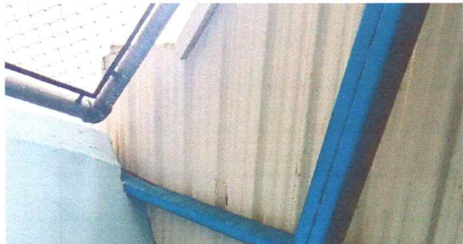
Foto1: Sustitución de lámina por lámina troquelada.
