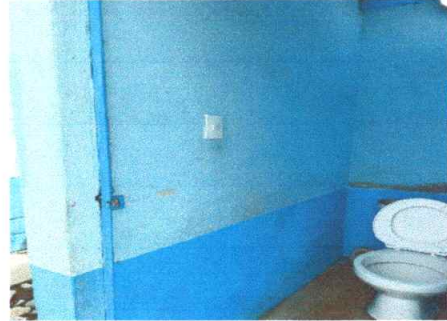
Foto 8: Instalación de azulejo
