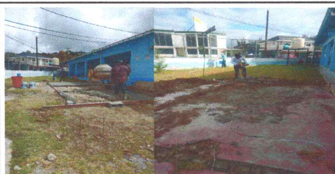
Foto 5: Reparación de plancha de concreto
