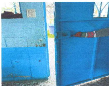
Foto 3: Sustitución de chapa
