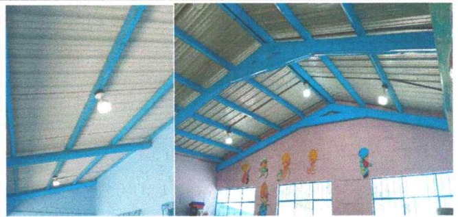
Foto 12: Sustitución de lámparas tipo led.
