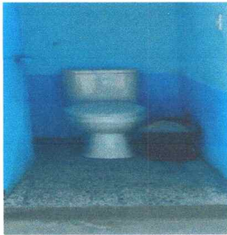
Foto 9: Instalación de piso de granito.
