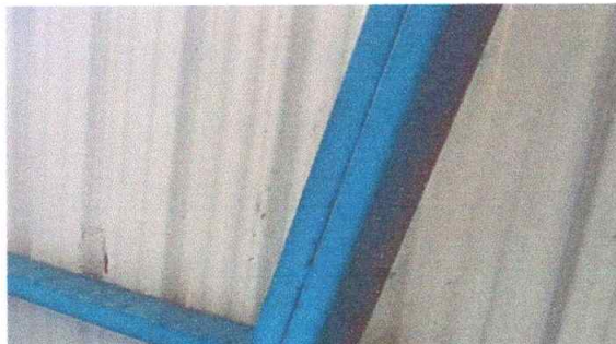
Foto2: Sustitución de estructura de soporte de metal.
