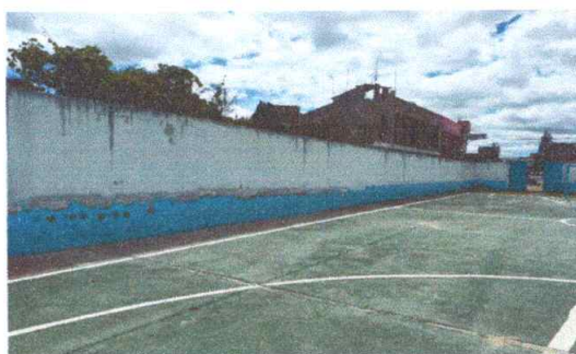
Foto 6: Aplicación de pintura en muro
