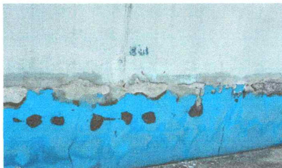
Foto 10: Repello de muro.
