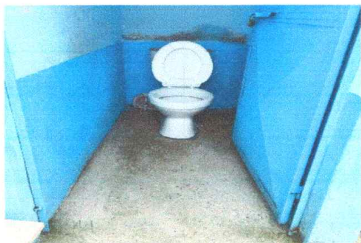
Foto 9: Instalación de piso de granito.
