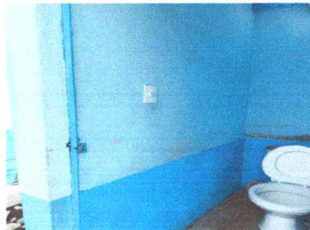
Foto 8: Instalación de azulejo
