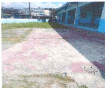
Foto 5: Reparación de plancha de concreto
