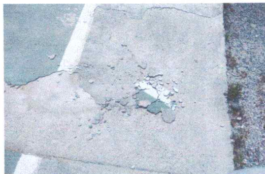
Foto 4: Sustitución de plancha de concreto.
