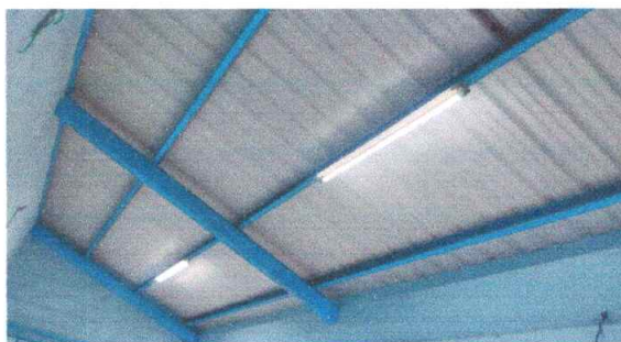
Foto 12: Sustrucción de lámparas tipo led.
