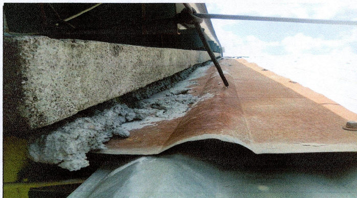
Foto 15: Reparación techos de lámina contra lámina 28 ML
