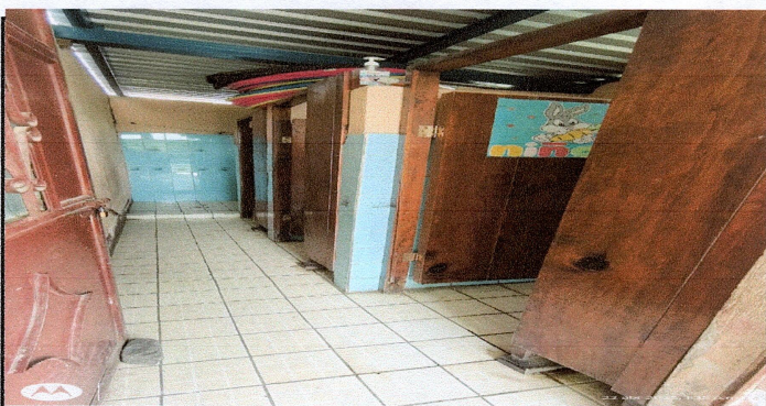
Foto 11: Sustitución de puertas en servicio sanitario
