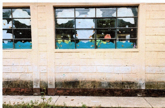
Foto 10: Impermeabilización de Losa y Pintura de Muros exteriores2
