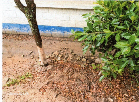
Foto 2: Reparación de cuneta y Drenaje
