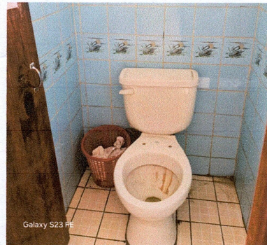
Foto 4: Sustitución de inodoro
