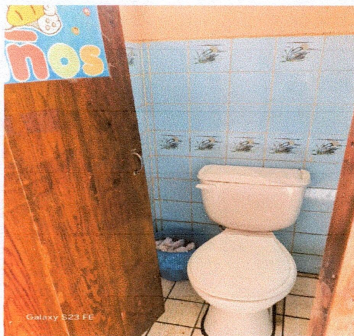
Foto 3: Sustitución de Puertas en servicios sanitarios
