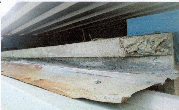
Foto 13: Impermeabilización de losa 28ML.
