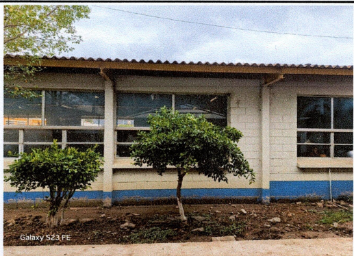
Foto7: Pintura de muros Exteriores
