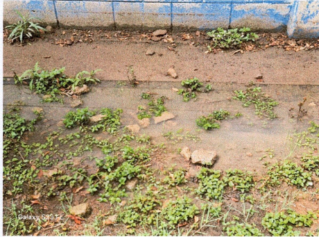
Foto 1: Reparación de cuneta y Drenaje
