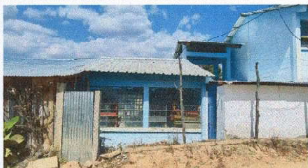
Foto 9: Mejoramiento canales de metal
