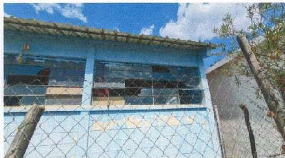
Foto 10: Mejoramiento canales de metal
