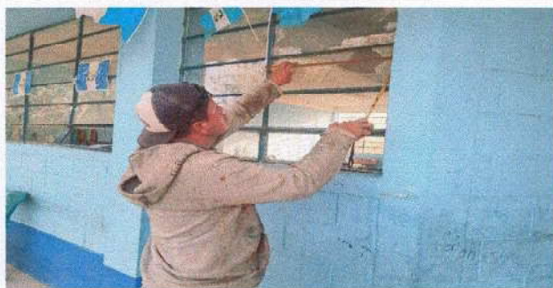
Foto 3: Sustitución vidrios de ventanas
