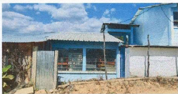
Foto 7: Sustrucción de láminas de metal por metal
