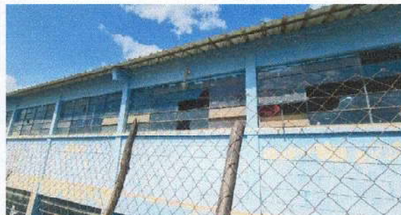
Foto 4: Sustitución vidrios de ventanas
