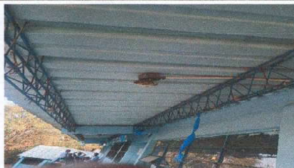
Foto 2: Sustitución cableado eléctrico
