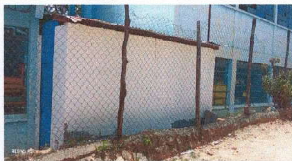
Foto 8: Sustrucción de láminas de metal por metal
