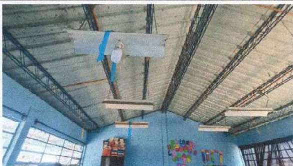
Foto1: Sustitución cableado eléctrico
