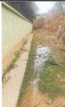
Foto 1: 8.1 Reparación de Cuneta de Concreto
