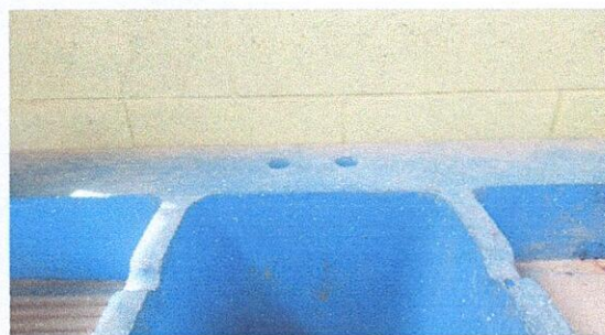
Foto 6: 13.13 Sustitución de llaves de chorro
