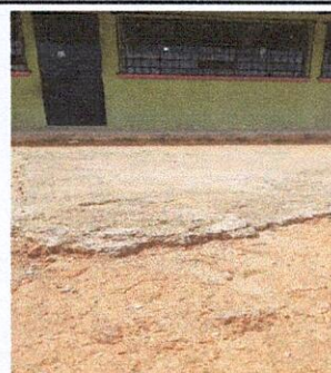
Foto 8:15.1 Reparación de Planchas de concreto de patio
