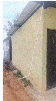
Foto 4: 13.8 Sustitución de tubería línea principal
