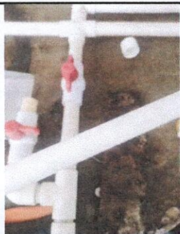
Foto 5: 13.11 Sustitución de llave de cheque
