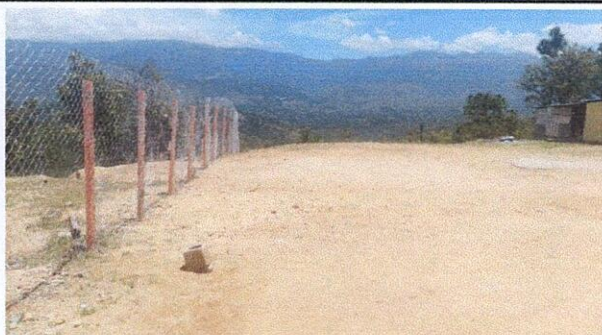
Foto 7: 14.1 Reparación de Tubo hg y malla galvanizada
