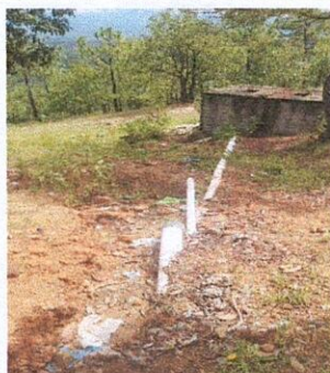
Foto 3: 13.3 Sustitución de tubería PVC lineal principal aguas negras
