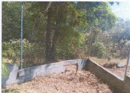
Foto 3: MEJORAMIENTO DE MURO PERIMETRAL BLOCK
