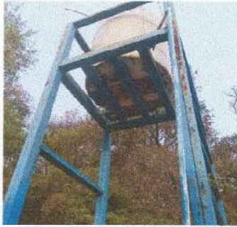
SUSTITUCIÓN DE DEPOSITO DE AGUA
