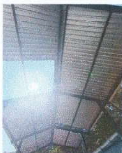
ESTRUCTURA DEL TECHO
