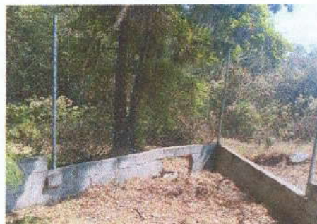
MEJORAMIENTO DE MURO PERIMETRAL
