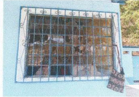
MEJORAMIENTO DE VENTANAS
