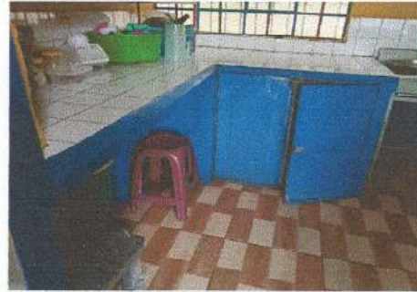
Foto 4: SUSTITUCIÓN DE PUERTAS DE COCINA
