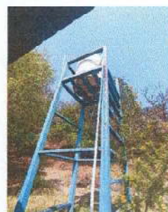
MANTENIMIENTO DE METAL DE DEPOSITO
