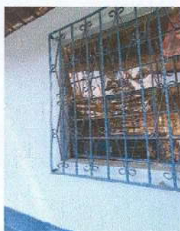
MANTENIMIENTO DE BALCONES
