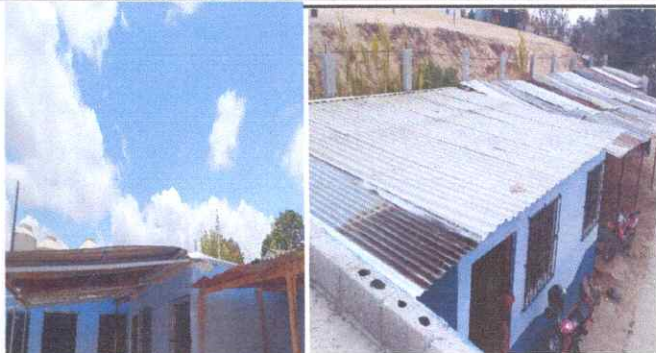
Foto 2: Cambio de lámina por lámina troquelada
