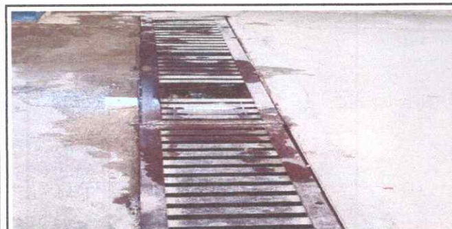
Foto 5: Mantenimiento y reparación de regillas para drenaje
