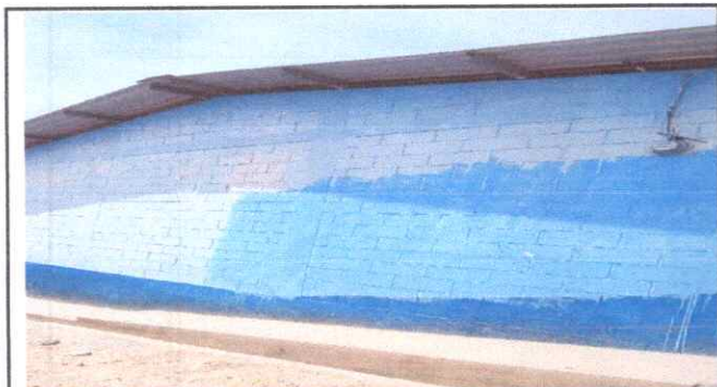
Foto 9: Pintura en muros interior y exterior
