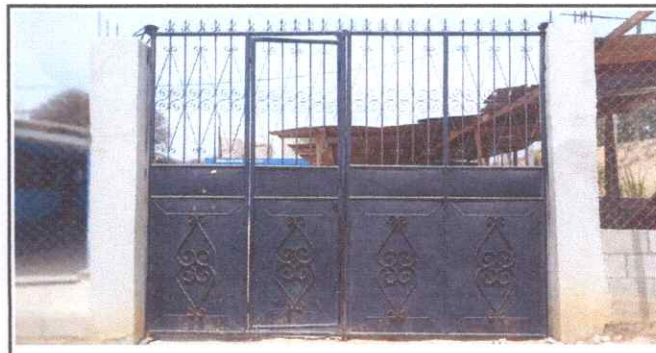
Foto 4: Mantenimiento de Portón
