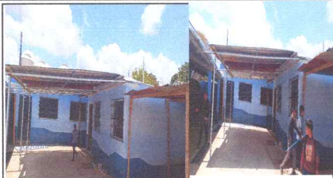
Foto1: Sustitución de estructura de madera por metal
