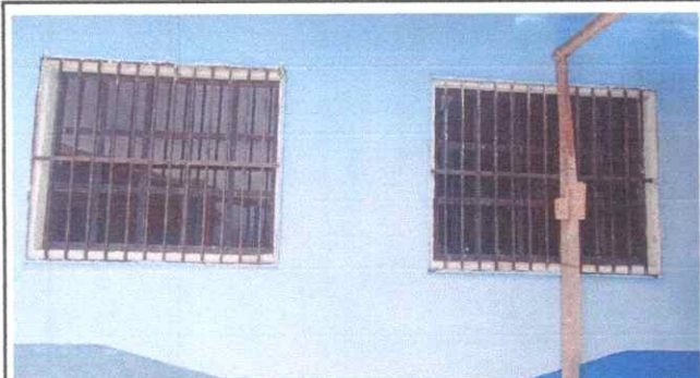
Foto 7: Mantenimiento de balcones
