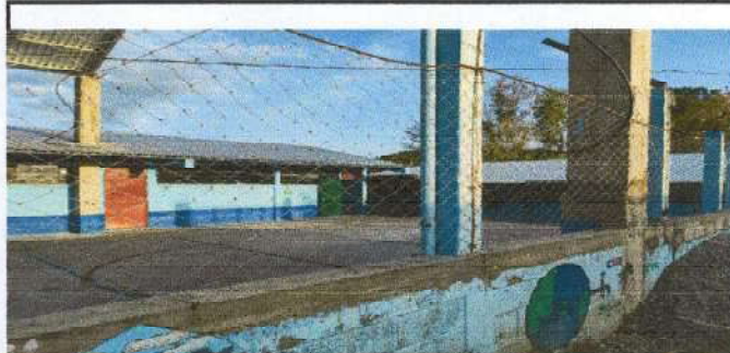
Foto 2: Sustitucion de barandas de meal
