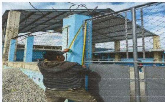
Foto : Sustitucion de porton principal
