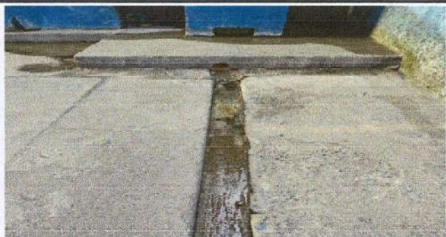
Foto1: Cunea de Concreto
