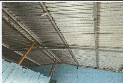
Foto : Reparacion del sistema Electrico
