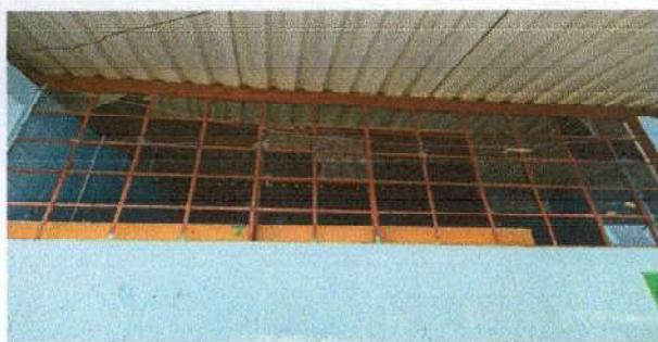
Foto 5: Sustitucion de vidrios
