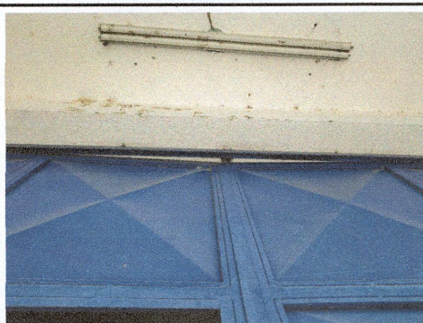
Foto 6: Portol principal dañado estructuralmente vista del exterior.
